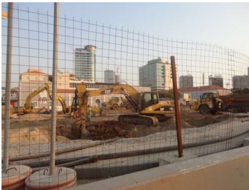
Figura 12: Obra na Av. 4 de Fevereiro (Marginal) no período da tarde.
