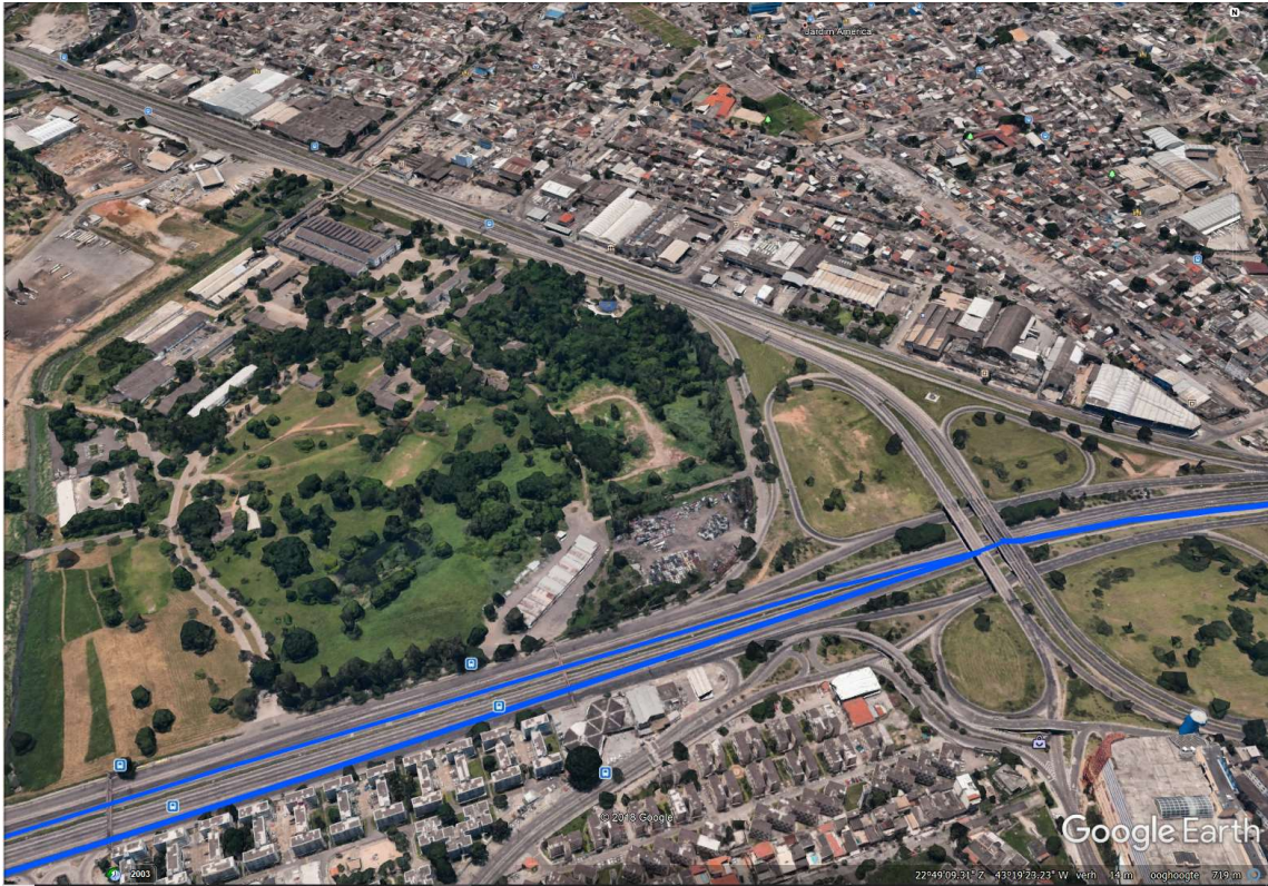
Figura 32 - Terminal de Margaridas - visão aérea (Google, 2003)
