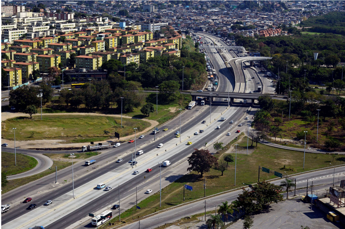
Figura 29 - Trevo das Missões com a visão do Viaduto de entrada no Terminal de Missões (João do Anjos, 2020)
