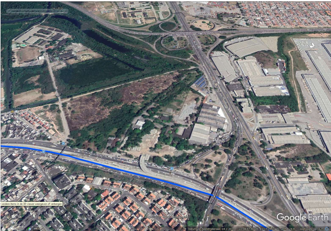
Figura 27 - Terminal de Missões - visão aérea (Google, 2019)
