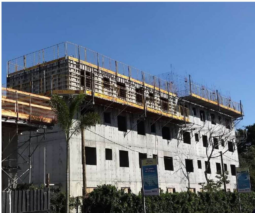
Figura 26 – Construção de edifício com sistema construtivo em parede de concreto com forma de alumínio de obra da MRV Engenharia Park Real Resort, Campo Grande / RJ Fonte: Acervo do Autor (2018)
