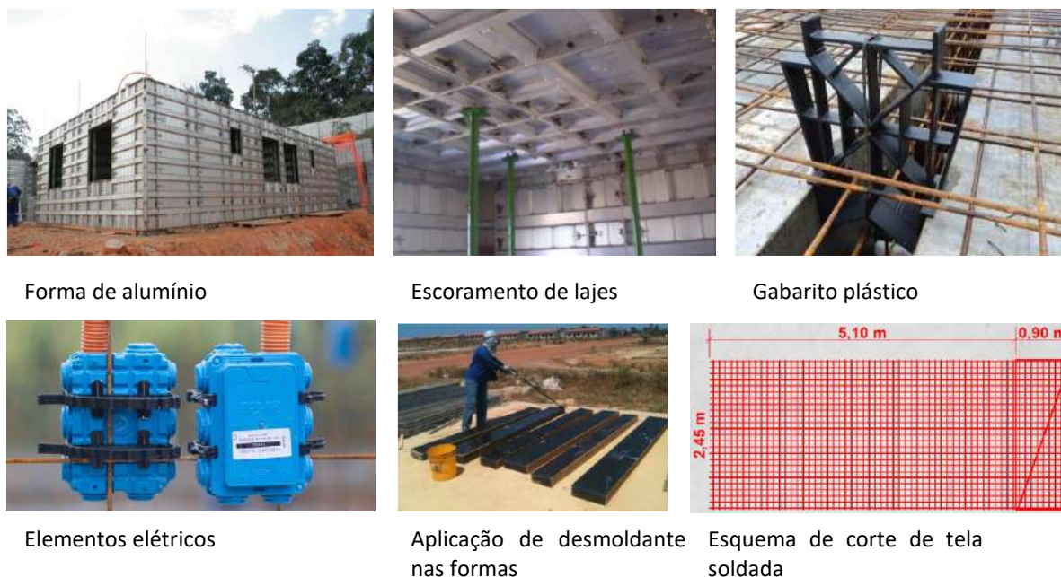
Figura 28 – Elementos constituintes do sistema construtivo de parede de concreto Fonte: (MONGE, 2019)
