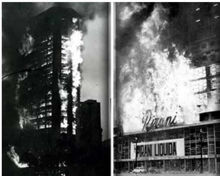
Figura 34 - O Edifício Andraus em chamas
