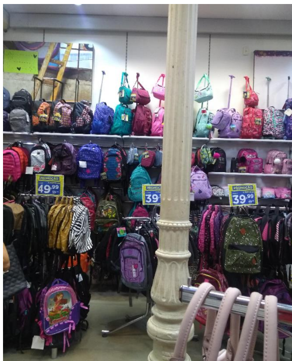
Figura 4F - Pilar em ferro fundido no interior da loja da edificação 6
