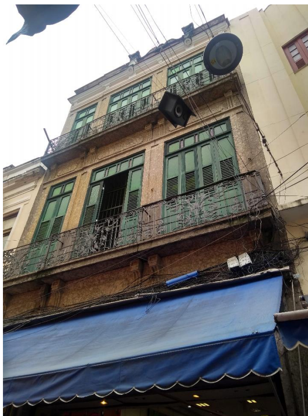
Figura 1F - Fachada da edificação 6
