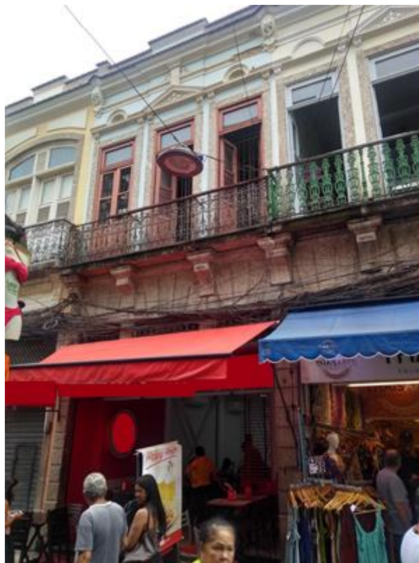
Figura 1B - Fachada da edificação 2
