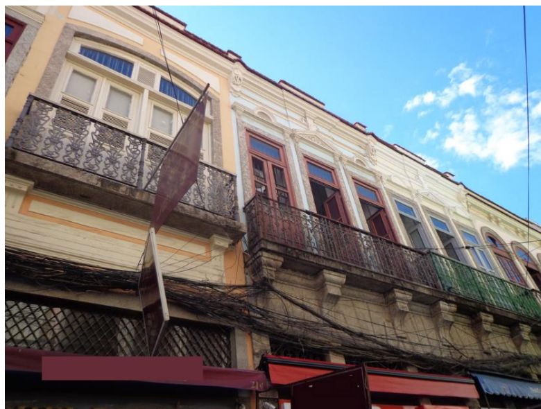
Figura 2B - Fachada do 2º pavimento da edificação 2 Fonte: A autora
