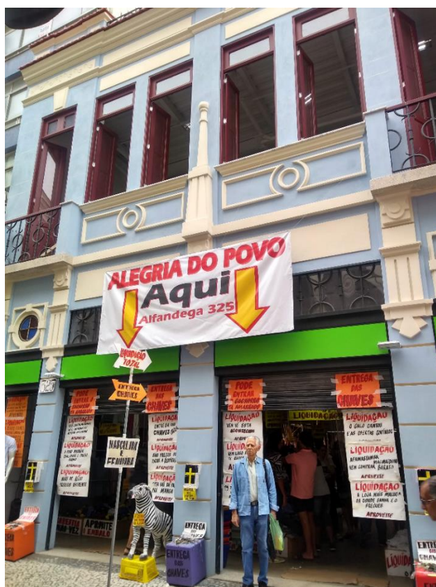
Figura 1E - Fachada da edificação 5
