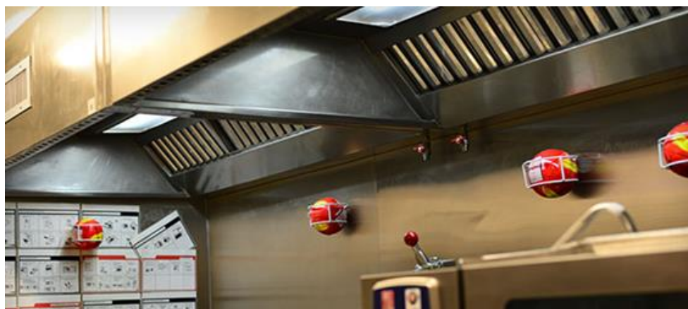
Figura 50 - Uso de bolas extintoras ABC em cozinha industrial (modo automático)
