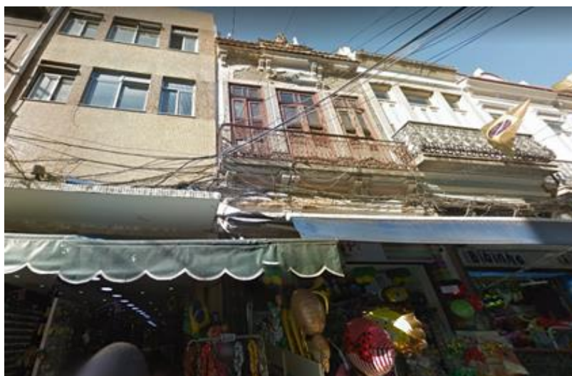
Figura 18 - Edificação com descaracterização da fachada
