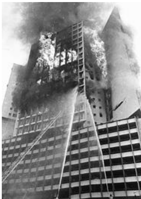
Figura 35 - Incêndio no Edifício Joelma
