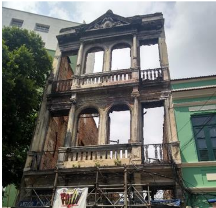
Figura 20 - Edificação com apenas a fachada preservada
