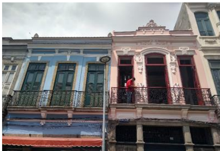
Figura 16 - Edificações em bom estado de conservação
