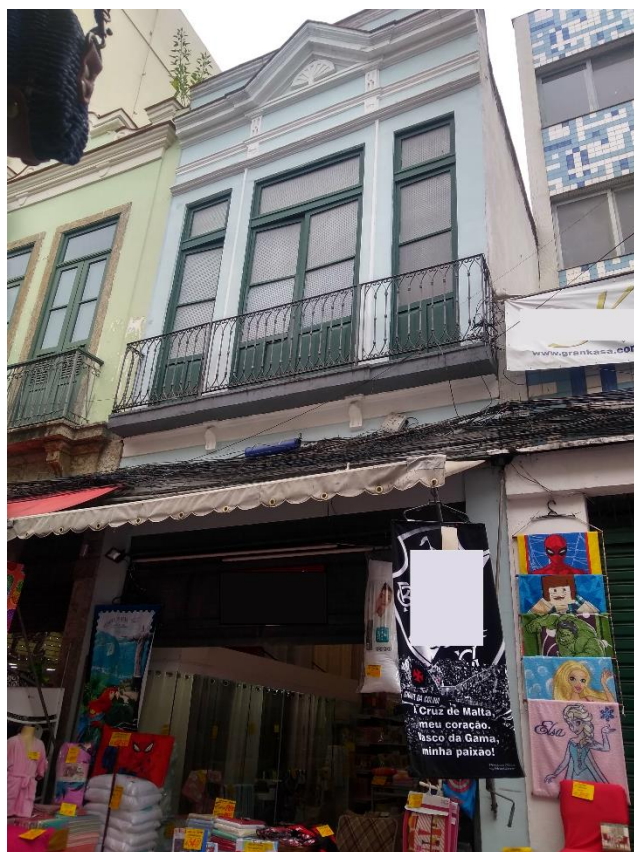
Figura 1C - Fachada da edificação 3
