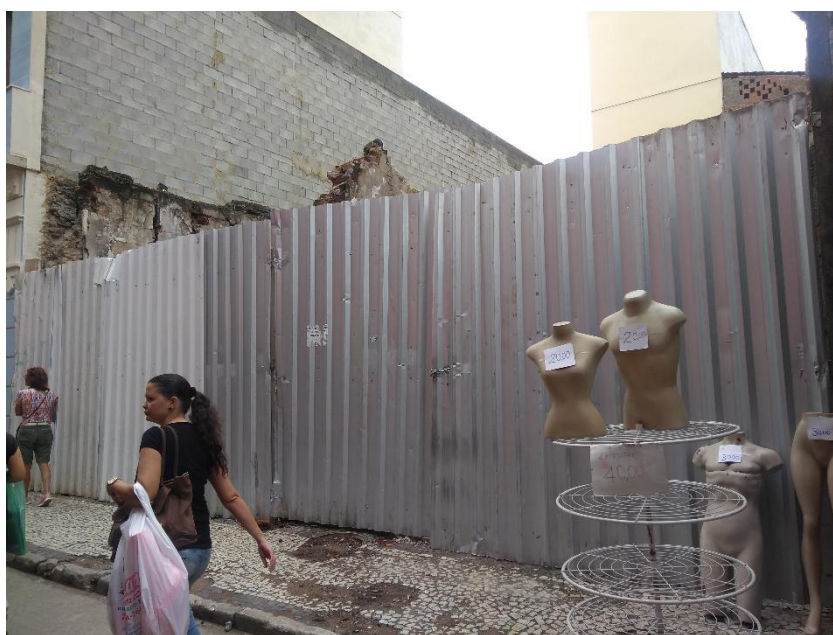
Figura 4E - Lotes vazios contíguos a edificação 5 devido ao incêndio
