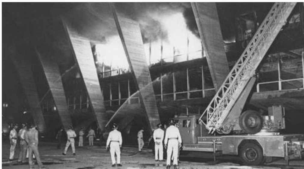
Figura 36 - Incêndio no MAM.
