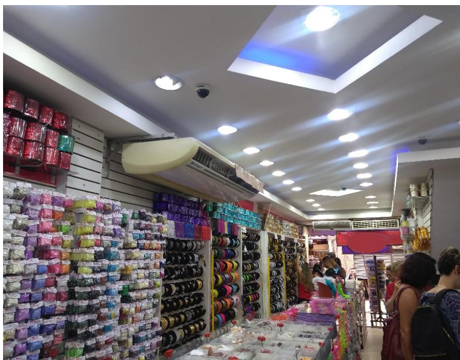
Figura 3A - Climatização e forro de gesso da edificação 1
