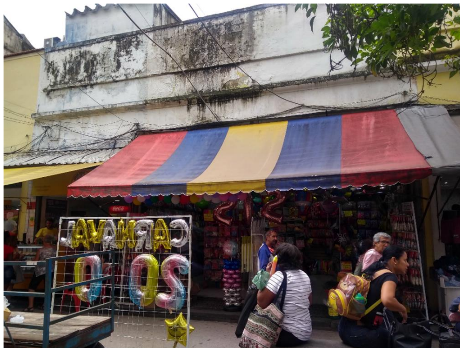
Figura 1D - Fachada da edificação 4
