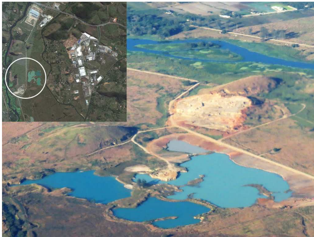
Figura 21 - Foto aérea do areal desativado – Distrito Industrial de Queimados/ Mosca de localização em rosa
