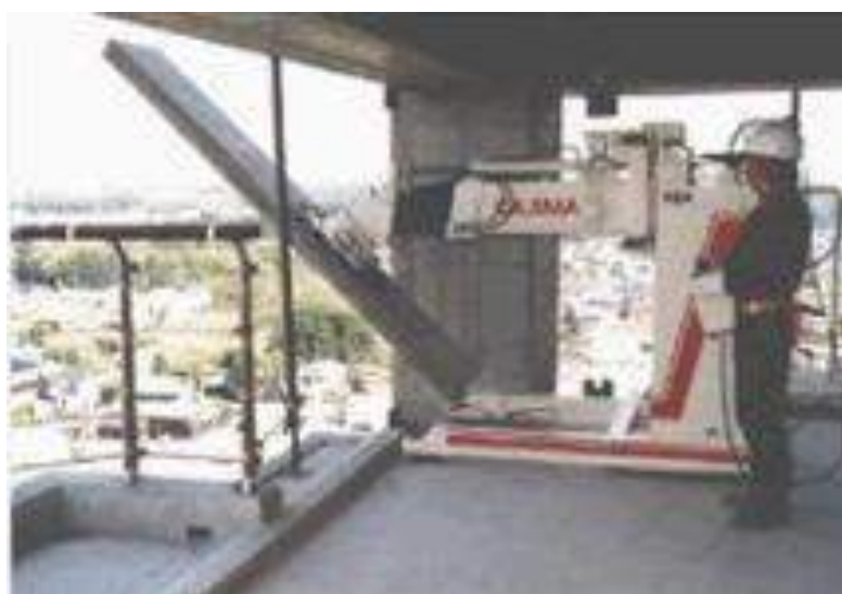
Figura 23. Robô de montagem de painéis "Mighty Hand". Fonte: Resino et al. (2005).
