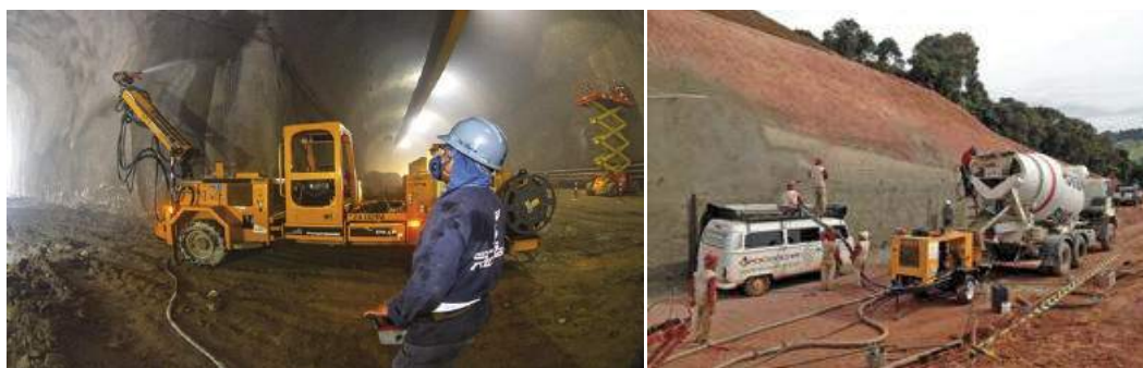
Figura 42. Robô Putzmeister em operação. Fonte: site O Globo (2013).
