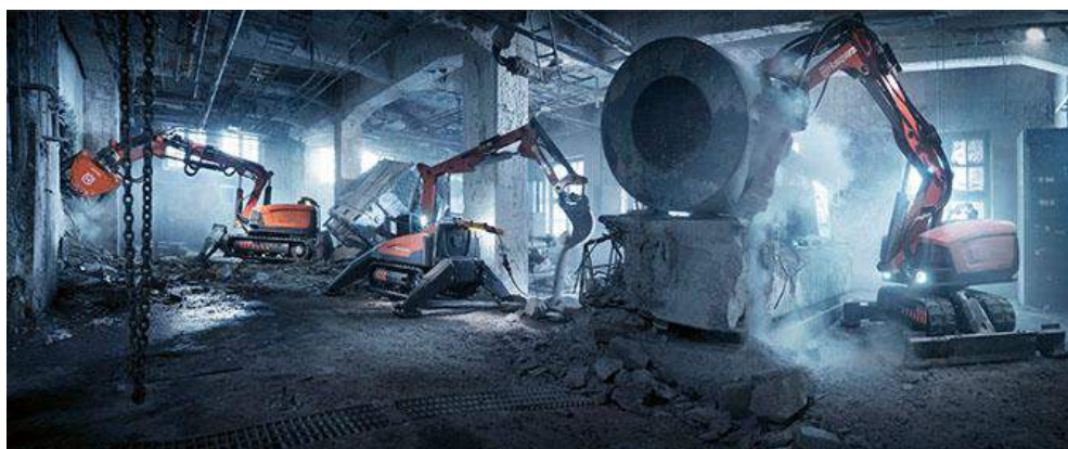
Figura 30. O processo da demolição. Fonte:site Portal dos equipamentos (2016).
