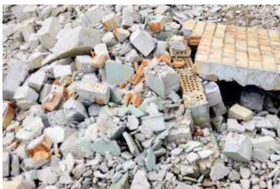
Figura 5. Entulho de construção. Fonte: site Pensamendo Verde (2014).
