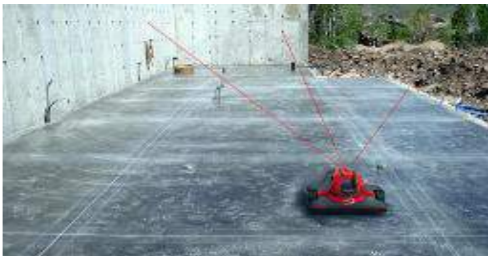
Figura 9: Robô-construtor usando scanner a laser para detectar erros na execução de projetos. Fonte: site Cimento Itambé (2014).
