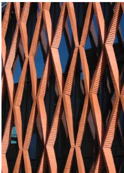
Figura 17. Fachata de tijolos retorcidos. Fonte: site ArchDaily.
