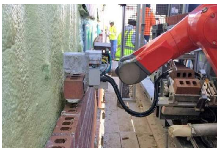
Figura 13. Robô SAM assentando tijolos. Fonte: site mapa da obra.
