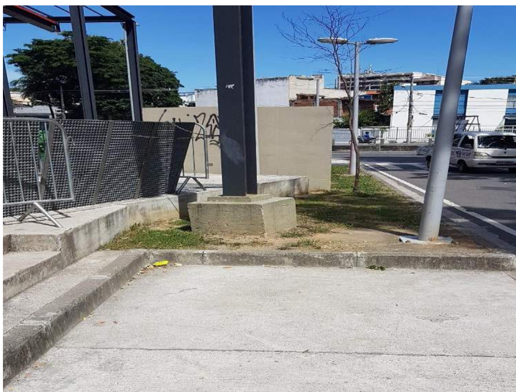
Figura 16: Local do recuo para caminhões pipa na Praça Varnhagem, dezembro/2017.
