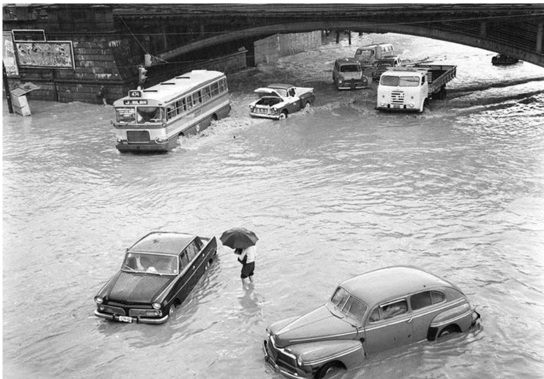
Figura 4b: Colapso do sistema de transporte na enchente de 1966.
