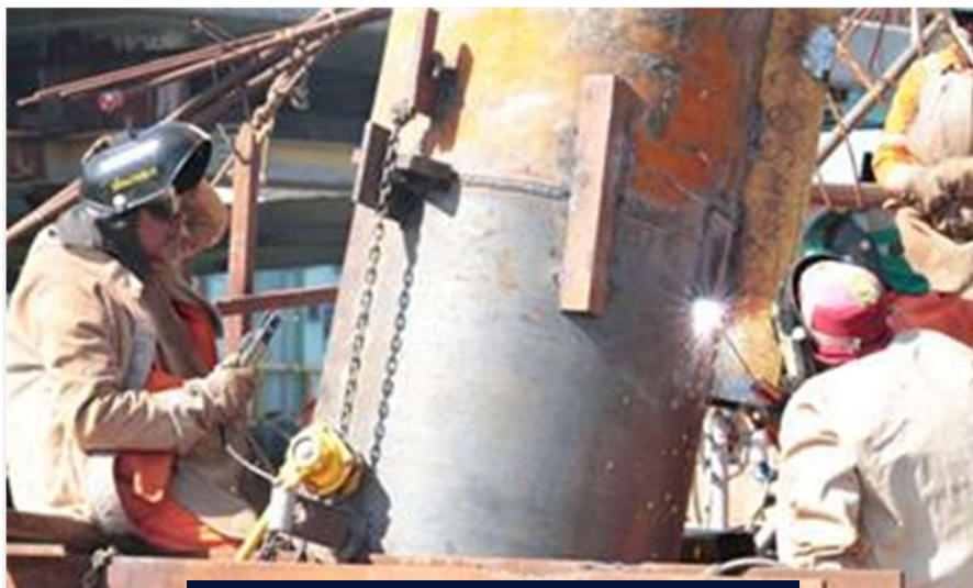
Complemento da camisa metálica (01/02/2013)
