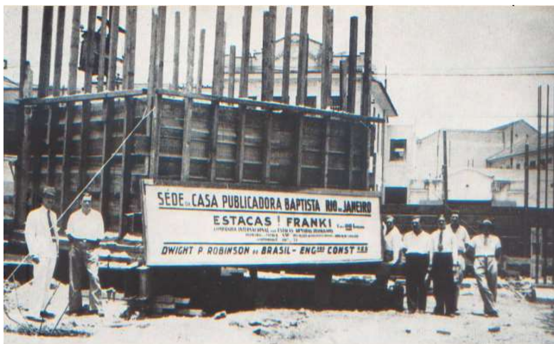
Figura 2.3 – Primeira Prova de Carga Estática (PCE) em estaca tipo Franki. Realizada no Brasil em 1935 – Caixa de areia com 1000kN. (ALONSO, 2013).
