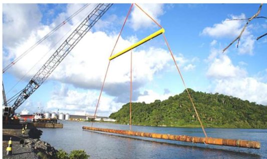
Posicionamento da camisa metálica na água
