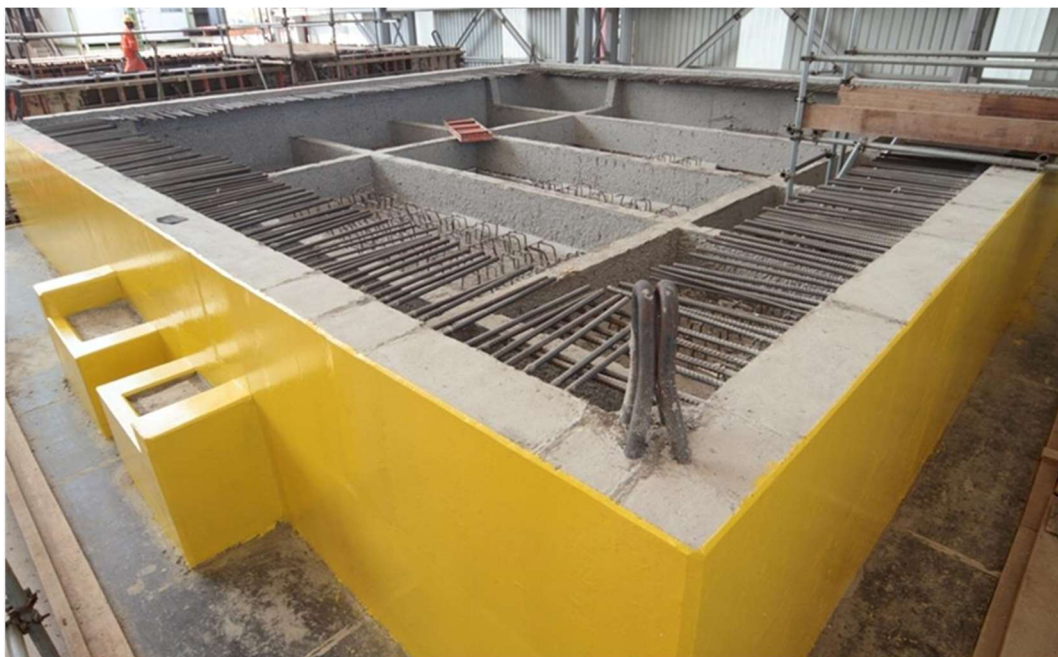
Figura Ap.2 – Pré-moldado concretado com pintura de proteção. - Fonte: Arquivos do Consórcio GNL-Bahia.
