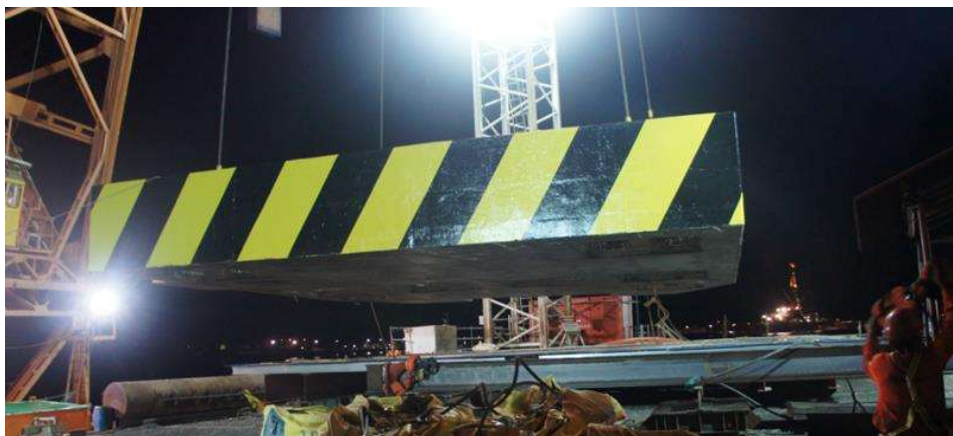
Figura Ap.7 – Grua/tubo preenchido com concreto/patesca/vagonetas/trilhos. Retirada do berço através da Cábrea Rondônia (1000kN). (17/04/13). - Fonte: Arquivos do Consórcio GNL-Bahia.
