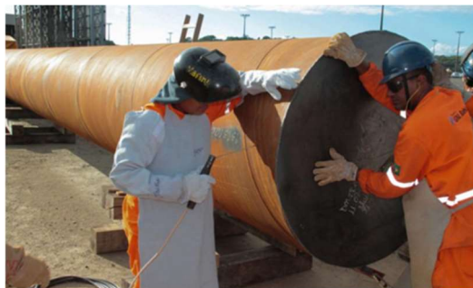
Tamponamento com chapa metálica
