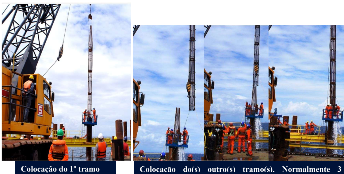
Figura 3.11 – Armação das estacas. - Fonte: Arquivos do Consórcio GNL-Bahia.
