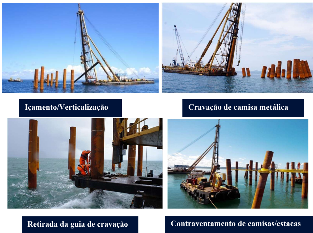
Figura 3.8 – Içamento, cravação, retirada da guia e contraventamento de camisas metálicas. - Fonte: Arquivos do Consórcio GNL-Bahia.
