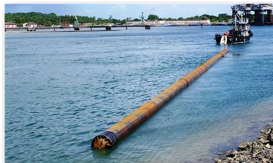
Tamponamento com compensado Naval + borracha
