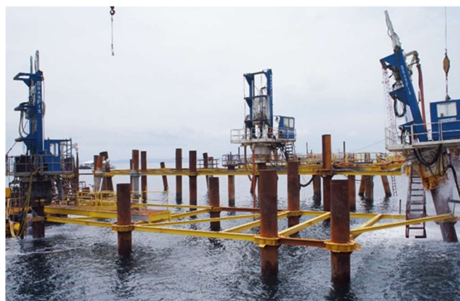
Figura 3.10 – Esquema de escavação/perfuração. - Fonte: Arquivos do Consórcio GNL-Bahia.
