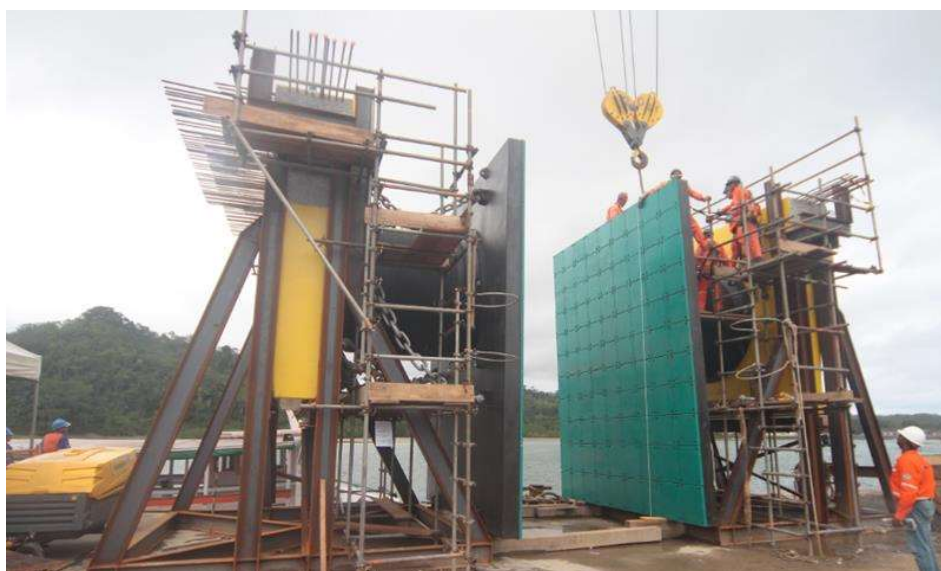
Figura Ap.9 – Pré-Montagem das defensas dos DATs 3 e 4 no canteiro da Ponta da Laje. (23/08/13). - Fonte: Arquivos do Consórcio GNL-Bahia.
