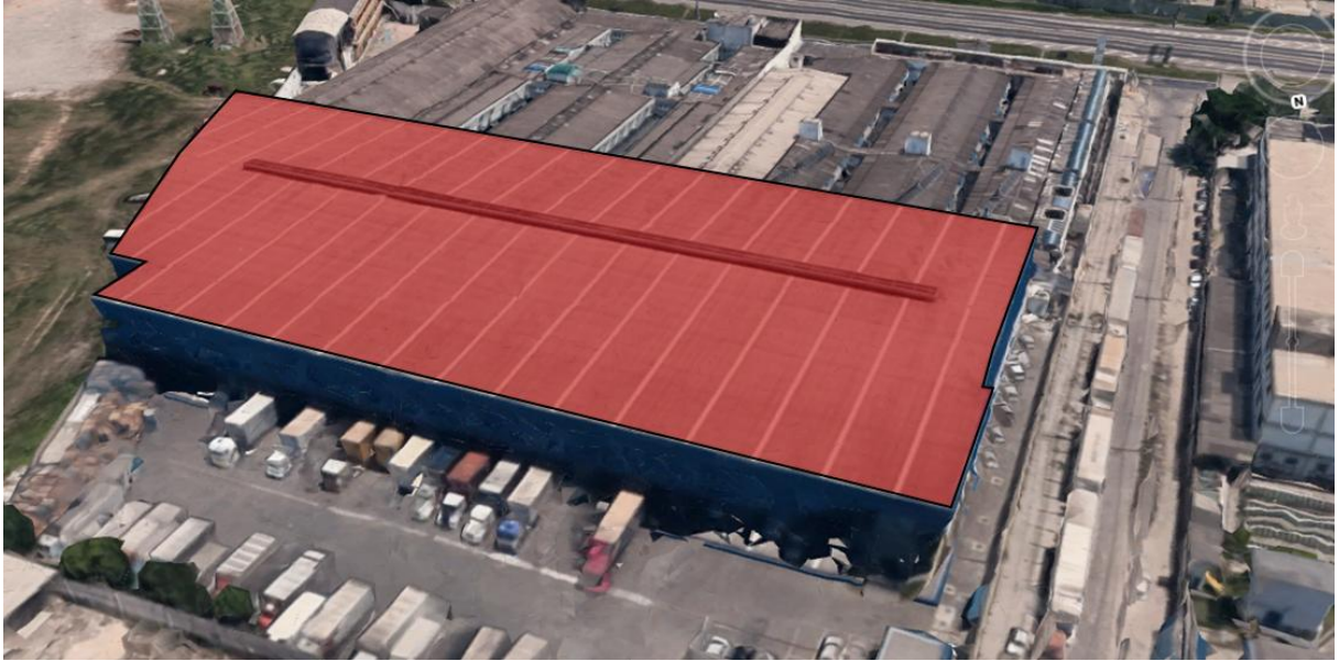
Figura 43: Telhado do Armazém de Distribuição.
