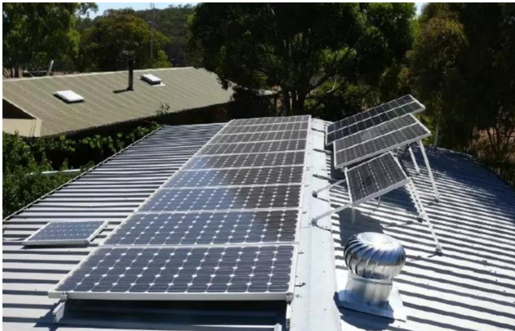
Figura 54: Instalação de placas fotovoltaicas sobre estrutura auxiliar para correção da inclinação do telhado.
