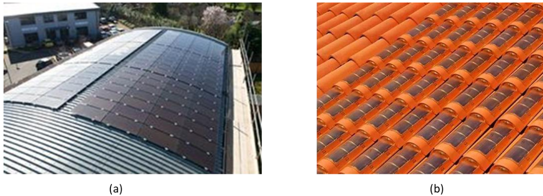
Figura 30: a) Painéis solares de filme fino oferecem uma solução mais estética num telhado curvado; b) Telhas cerâmicas com células solares de filme fino
