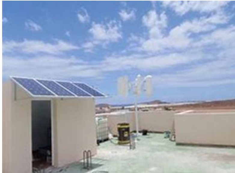
Figura 32: Sistema Híbrido de fonte Solar e Eólica.
