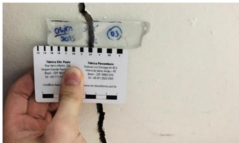
Figura 26: Medição das trincas pela Concessionária Porto Novo (Fonte: Relatório da EGT Engenharia).
