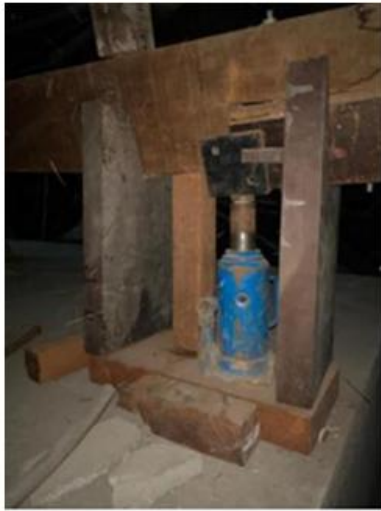
Figura 44: Macacos manuais utilizados para realinhar a estrutura do telhado (Fonte: Teprem Engenharia)
