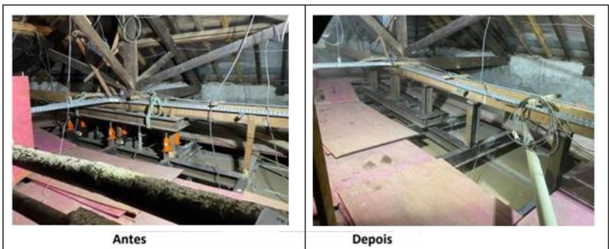
Figura 43: Troca dos antigos apoios de madeira por perfis metálicos (Fonte: Teprem Engenharia)
