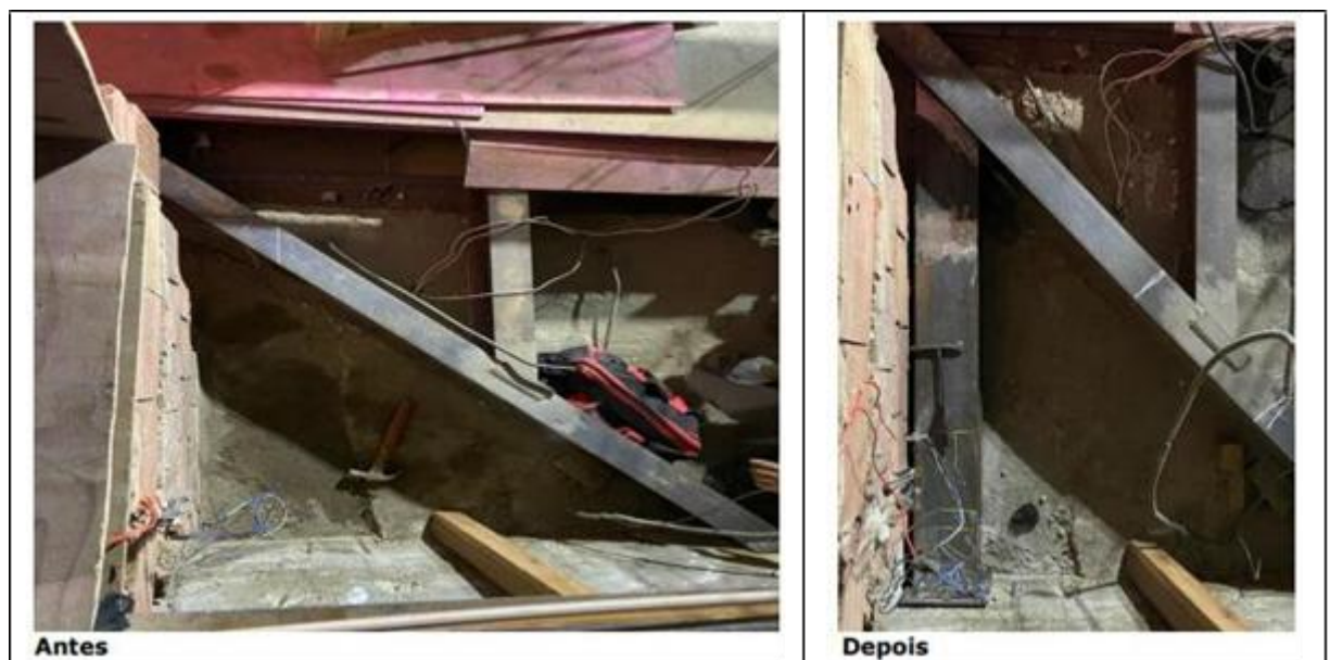
Figura 42: Inserção de novo perfil metálico na estrutura existente (Fonte: Teprem Engenharia)
