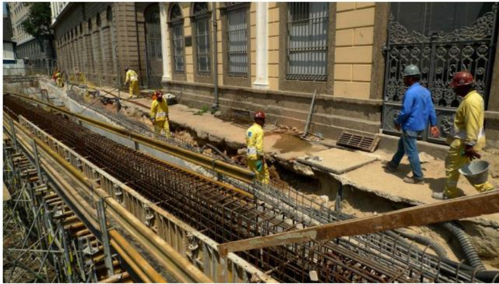
Figura 17: Execução da laje de topo no antigo mergulhão (fonte: Laudo da ARS Urbe).
