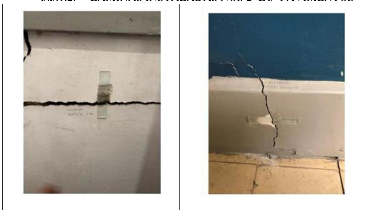
Figura 31: Lâminas 03 e 04 do 2º e 3º pavimentos (Fonte: Relatório de instalação da Porto Novo)
