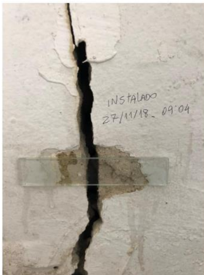
Figura 32: Lâmina 05 instalada no Sótão (Fonte: Relatório de instalação da Porto Novo)
