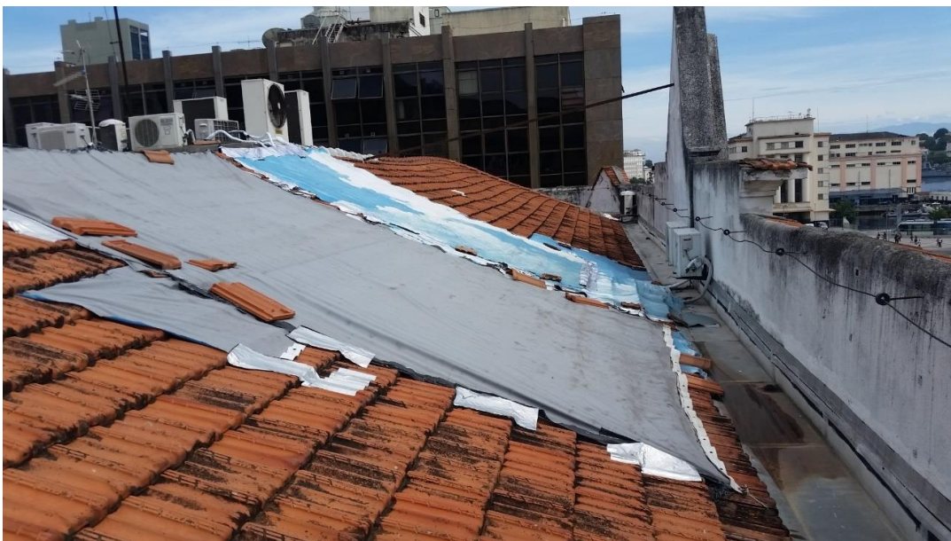
Figura 36: Paliativo para prevenir vazamentos dentro do museu (Fonte: Relatório ABS)
