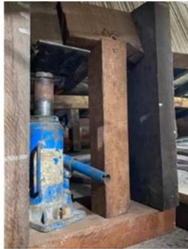
Figura 44: Macacos manuais utilizados para realinhar a estrutura do telhado (Fonte: Teprem Engenharia)
