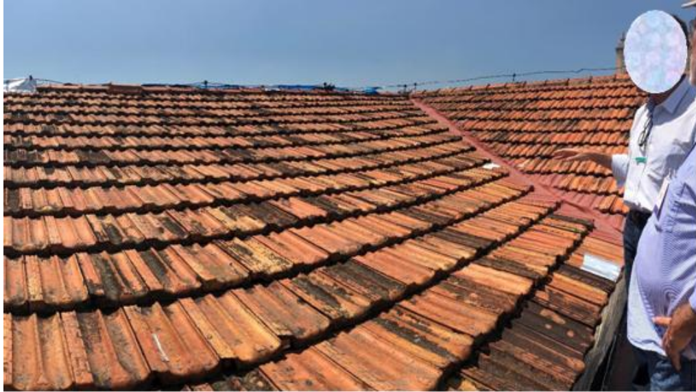
Figura 37: Inspeção técnica quanto aos danos no telhado do museu (Fonte: Relatório ABS)
