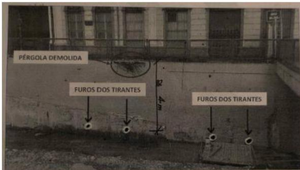
Figura 18: Execução dos tirantes junto ao Museu Naval (fonte: Laudo ARS Urbe).
