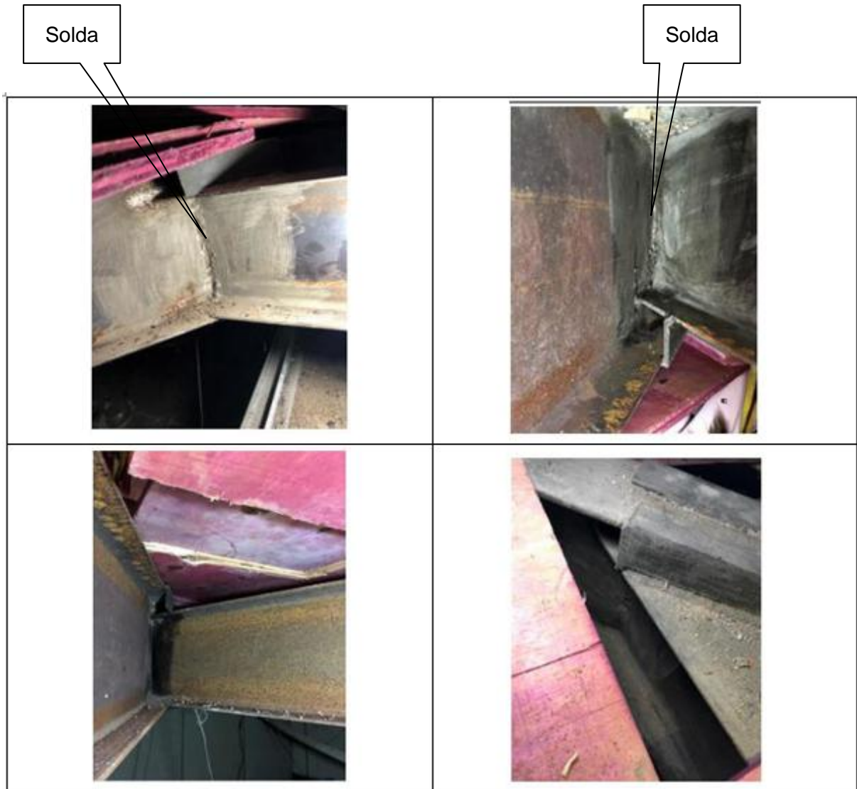
Figura 41: Reforços por processo de solda da estrutura metálica existente (Fonte: Teprem Engenharia)
