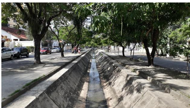
Figura 74: Canal com Seção em U entre as Duas Pistas da Av. Almirante Ary Parreiras.
