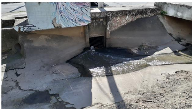
Figura 78: Captação de Tempo Seco no Canal da Ary Parreiras, Próximo a R. Lemos Cunha.
