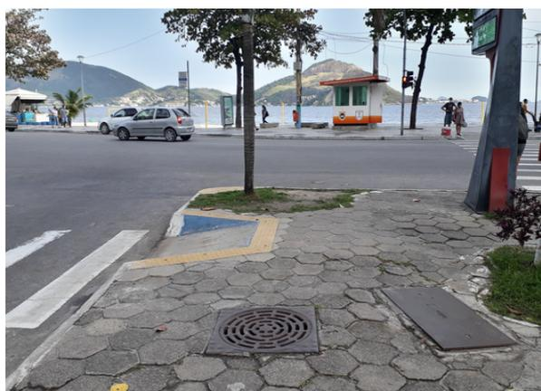
Figura 49: PV de Drenagem com Fluxo de Água, Tampão Perfurado, R. Miguel de Frias com Av. Jor. Alberto Torres.
