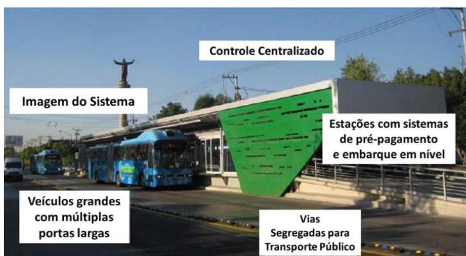
Figura 18: Componentes do sistema BRT
