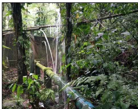
Figura 49 – Reservatório São Roque.
