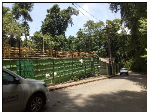
Figura 44 – ETA Pedra Branca.
