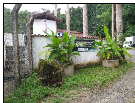
Figura 60 – ETE Praia Grande.
