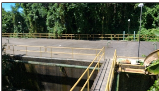
Figura 46 – Reservatório Vila de Mambucaba.
