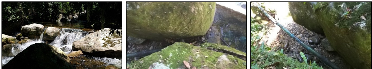
Figura 14 – Captação Barra Grande.
