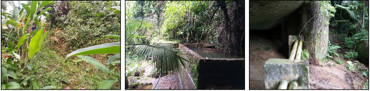
Figura 16 – Captação Praia Grande.
