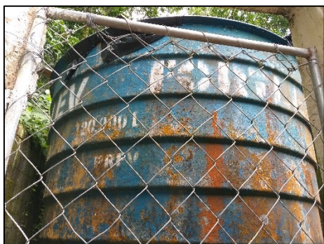
Figura 52 – Reservatório Praia Grande.
