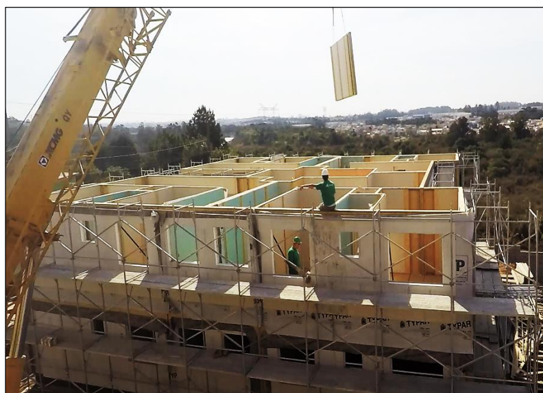
Figura 28 - Prédio Construído em Sistema Wood Frame Fonte: Tecverde (2016)
