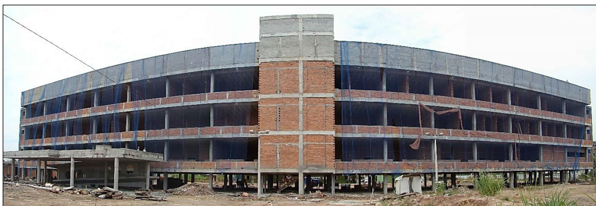
Figura 15 - Conclusão da Superestrutura e Alvenaria - LADETEC – IQ-UFRJ Fonte: ETU - Escritório Técnico da UFRJ (2014)
