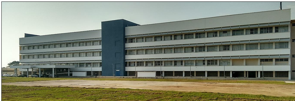
Figura 17 - Conclusão do Prédio - LADETEC – IQ-UFRJ Fonte: ETU - Escritório Técnico da UFRJ (2016)
