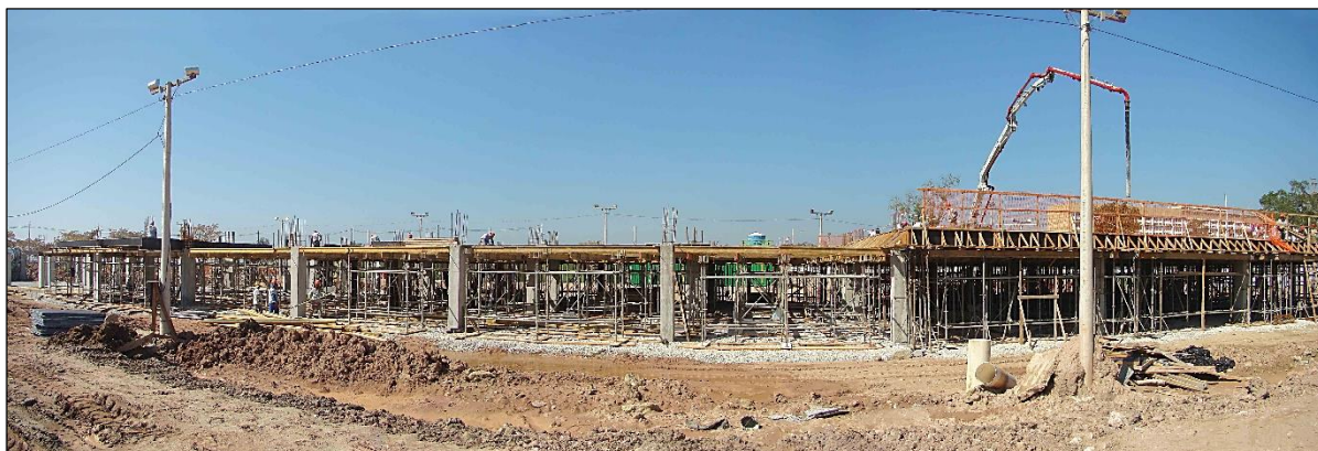
Figura 13 - Execução da Superestrutura - LADETEC – IQ-UFRJ Fonte: ETU - Escritório Técnico da UFRJ (2013)
