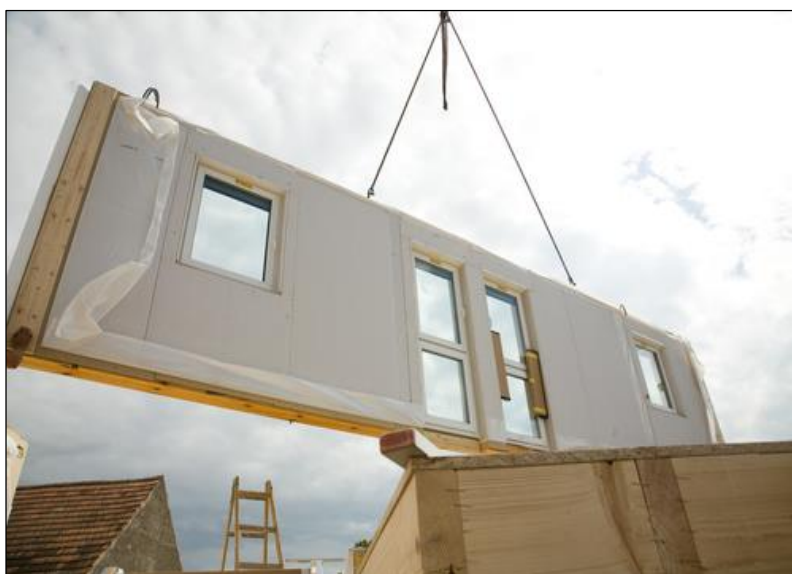
Figura 22 - Painelização – Elemento Não Volumétrico 2D Fonte: MBI (2019)
