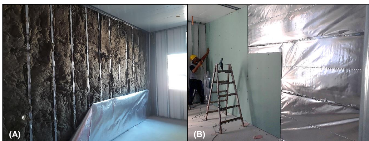
Figura 31 - (A) Isolamento Termoacústico (Lã de Rocha) – (B) Manta de Alumínio Fonte: O autor (2020)
