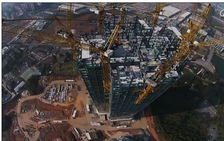
Figura 38 - Montagem - Prédio Mini Sky City - China Fonte: Civilização Engenheira (2017)
