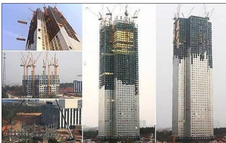
Figura 39 - Desenvolvimento - Prédio Mini Sky City - China Fonte: Civilização Engenheira (2017)
