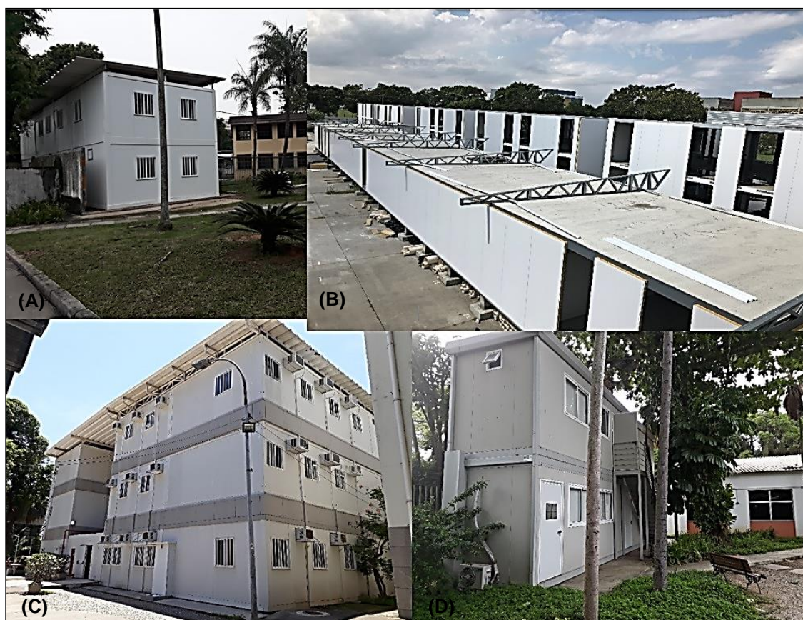
Figura 42 - Construções Modulares nos Campus da UFRJ – (A) Módulo Administrativo ETU – (B) Alojamento Estudantil – (C) Salas de Aula PV – (D) Módulo Administrativo IESC Fonte: O autor (2018)
