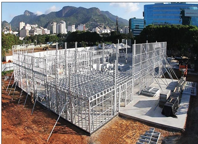
Figura 26 - Utilização do LSF na Construção do Pavilhão Olímpico-RJ Fonte: ABCEM (2016)
