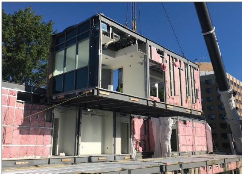
Figura 21 - Construção Modular Volumétrica 3D – Gotham Health (NYC) Fonte: MBI (2019)
