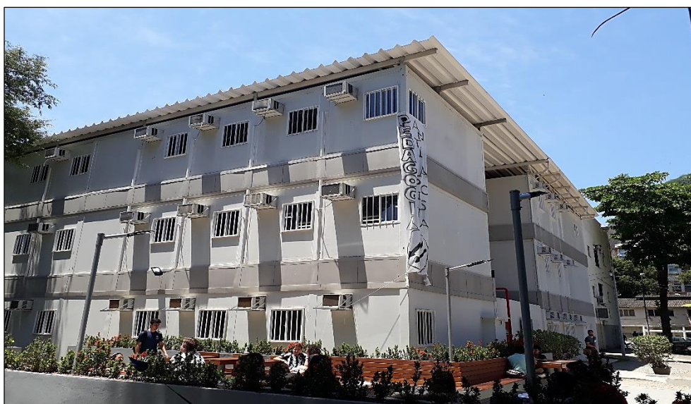
Figura 36 - Unidades Modulares Pré Fabricadas – Aulário – Campus PV - UFRJ Fonte: O autor (2018)
