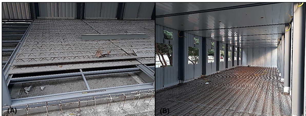
Figura 51 - (A) Painel Pré-laje – (B) Laje de Piso Pré-Moldada Fonte: O autor (2020)
