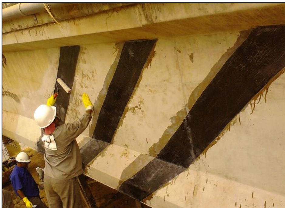
Figura 40: Aplicação de fibra de carbono para reforço ao cisalhamento. (PIRES GIOVANETTI GUARDIA Engenharia, 2014)
