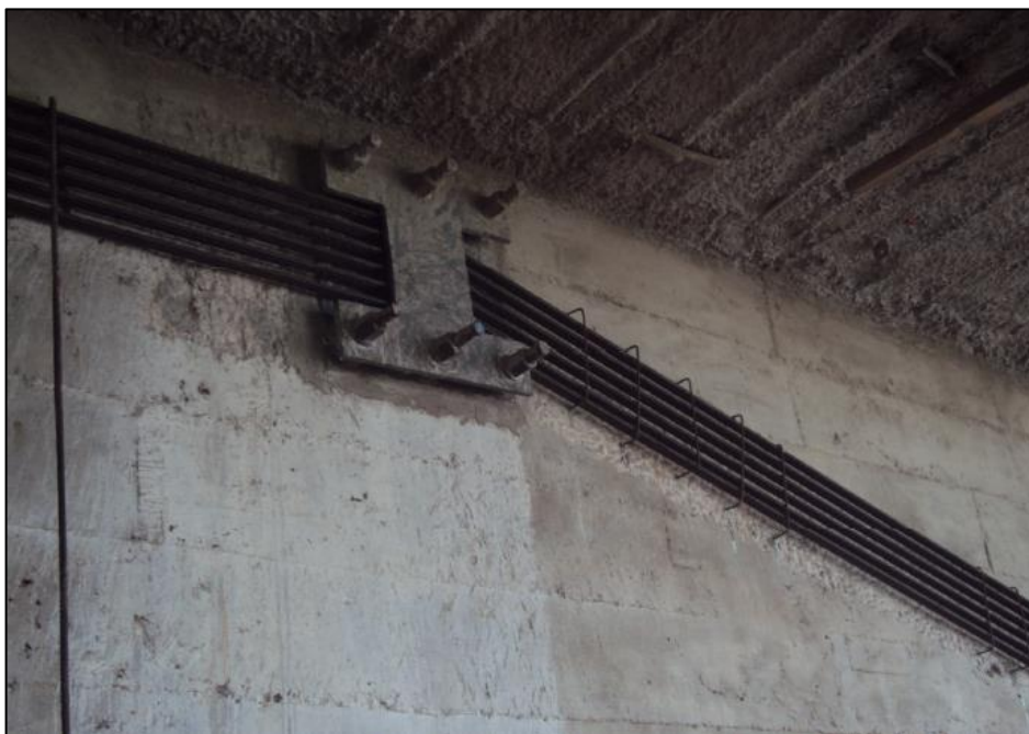
Figura 35: Exemplos de desviadores metálicos na região superior da viga. (VITÓRIO, J. A. P.; DE BARROS, R. C., 2011)
