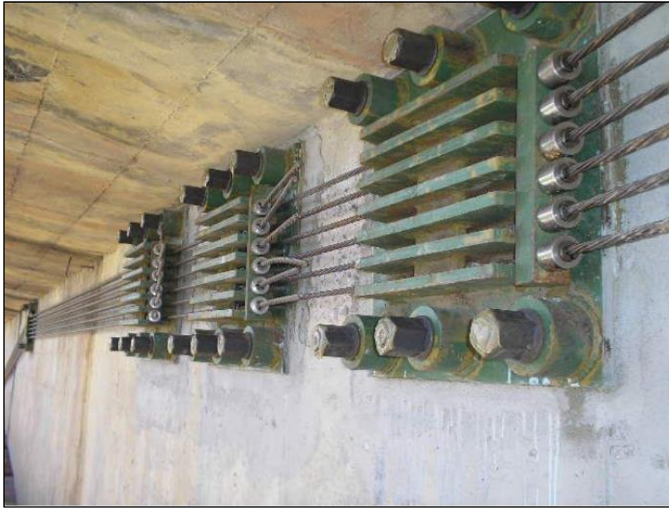
Figura 34: Exemplos de desviadores metálicos. (VITÓRIO, J. A. P.; DE BARROS, R. C., 2011)
