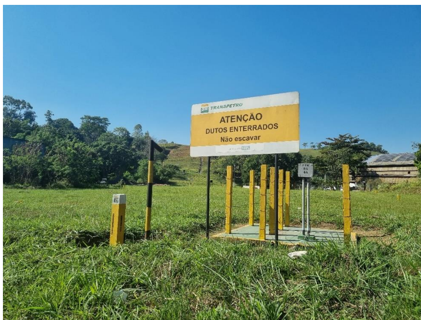
Figura 39- Placa de segurança indicando de faixa de domínio de dutos enterrados no 2º distrito de Duque de Caxias.
