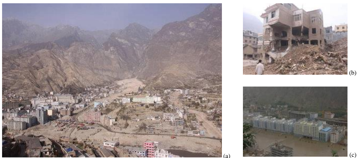
Figura 9 - (a) Cidade de Zhouqu destruída pelo fluxo de detritos; (b) Edifícios atingidos na zona de deposição; (c) Município inundado a montante do rio Bailong, que foi bloqueado pelos fluxos de detritos.
