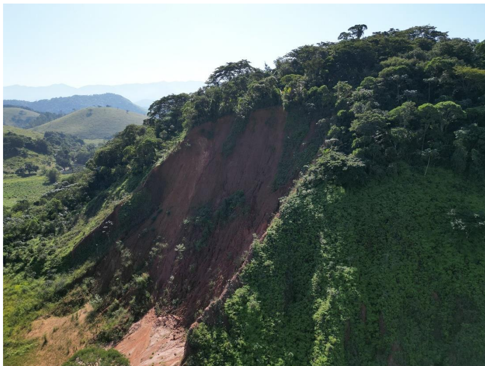
Figura 86 - Escorregamento em encosta da área 5, porção norte.
