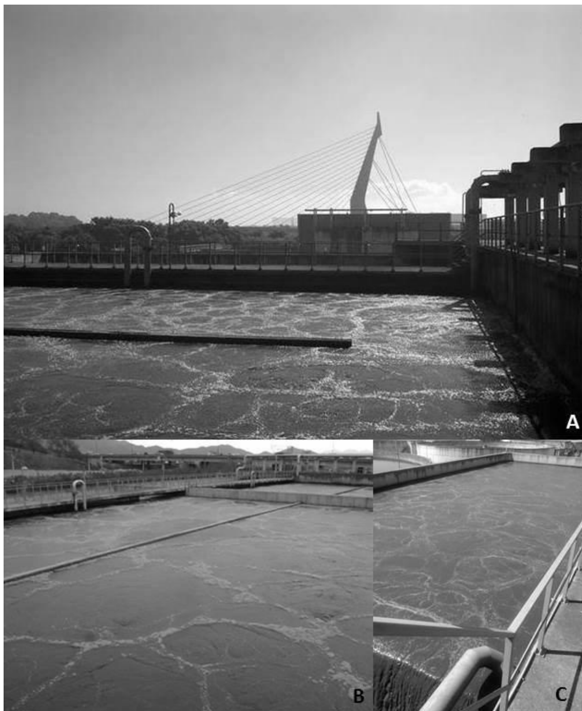
Figura 3.2 A, B e C: Tanques de aeração da ETE Alegria.
