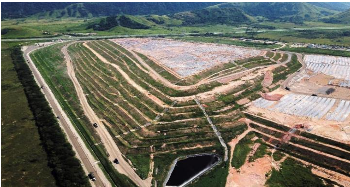
Figura 13: Vista aérea do CTR-Rio Fonte: COMLURB
