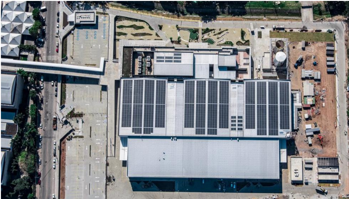
Figura 22: vista superior da implantação do MG4 e usina fotovoltaica inaugurada em 2019
