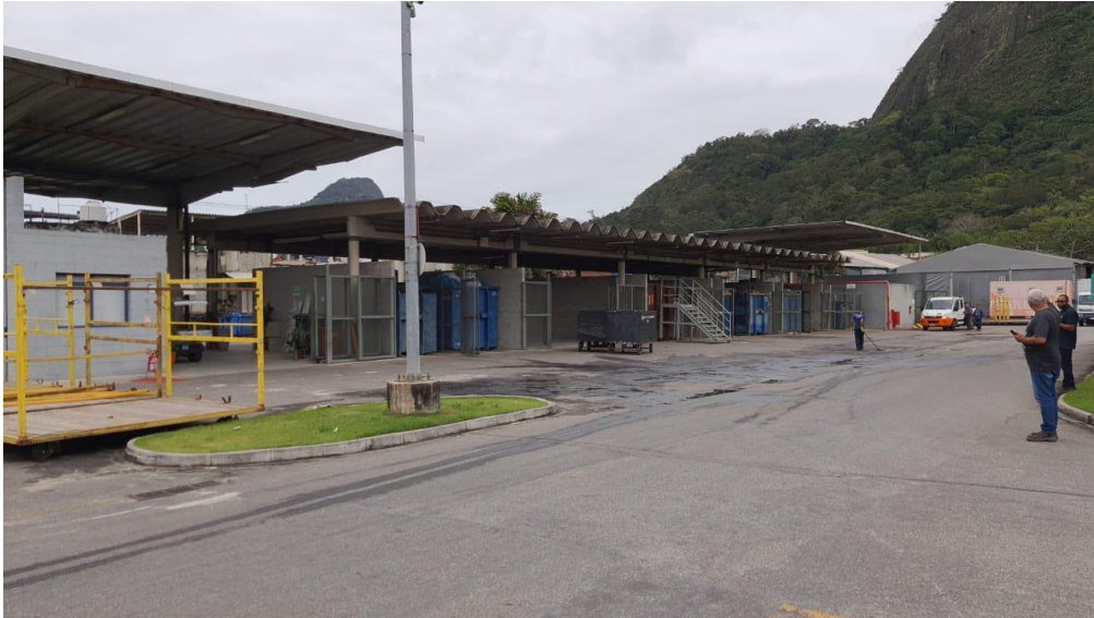
Figura 28: Central de resíduos – Lado A
