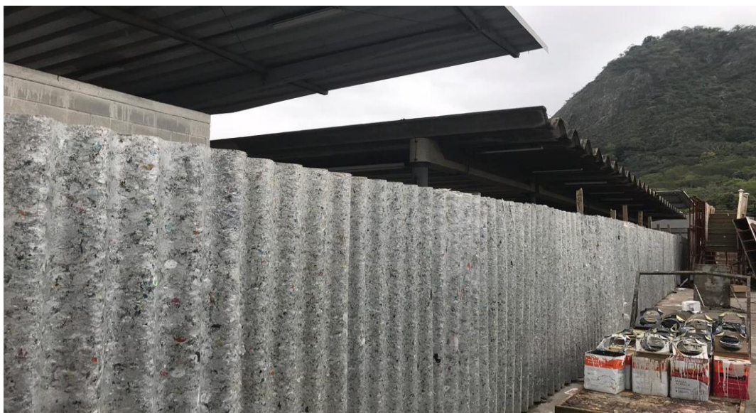
Figura 40: aplicação de tapumes sustentáveis na reforma da Central de Resíduos
