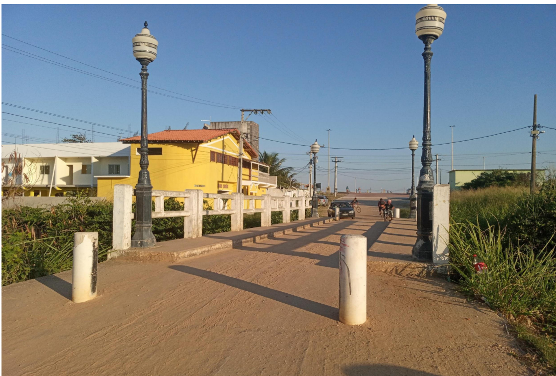
Figura 4.8 - Ponte da Avenida 1, construída em outubro de 2015. Fonte: Arquivo da autora, 2021.
