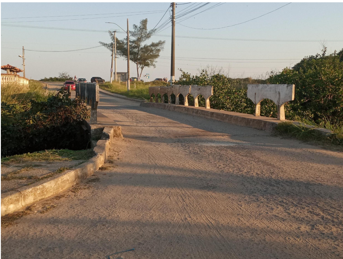
Figura 4.10 - Ponte da Rua 47.
