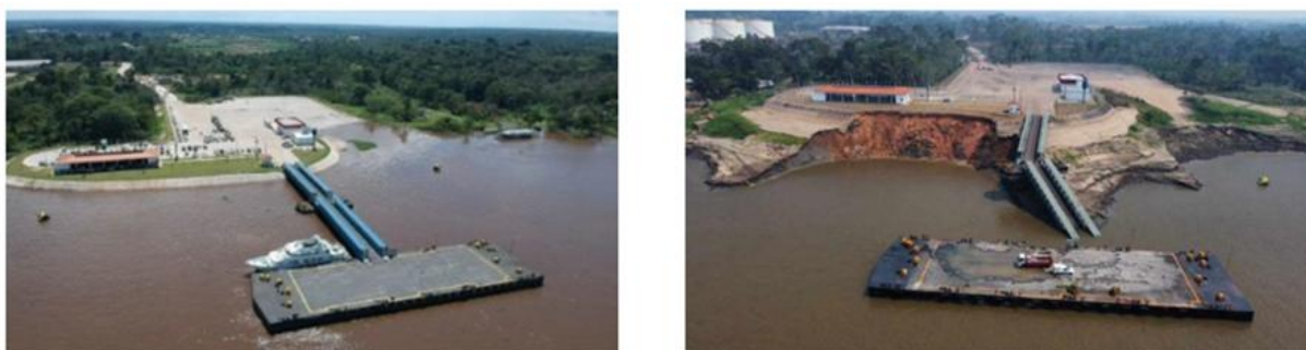
Figura 2-1- A esquerda o porto federal Antônio Nelson de Oliveira Neto e a direita o porto após o colapso.
