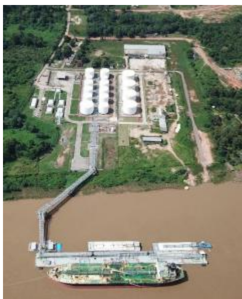
Figura 2-4- Terminal de armazenamento de combustíveis em Itacoatiara.
