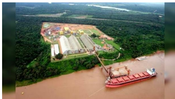
Figura 2-3- Terminal graneleiro Hermasa.
