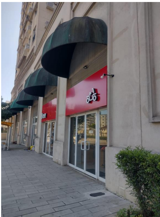
Figura 60: Polo de lojas em desenvolvimento no Eixo da Av. Marquês do Paraná Fonte: Próprio Autor, 2020
