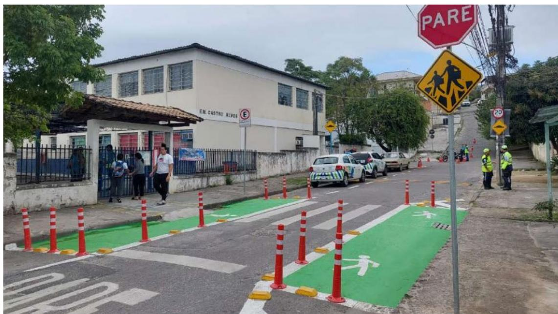
Figura 77 - Renovação da sinalização vertical e horizontal, alargamento de calçada e estreitamento de via no entorno da Escola Municipal Castro Alves - Bairro Campo Grande
