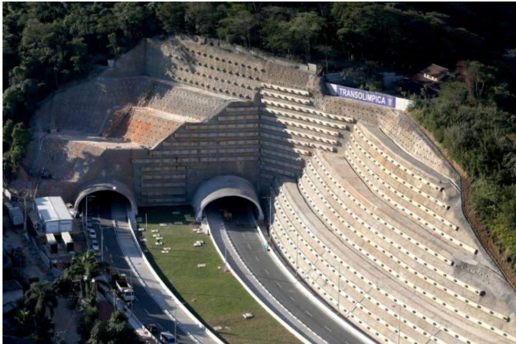
Figura 14: Emboque do sul do túnel Boiuna.
