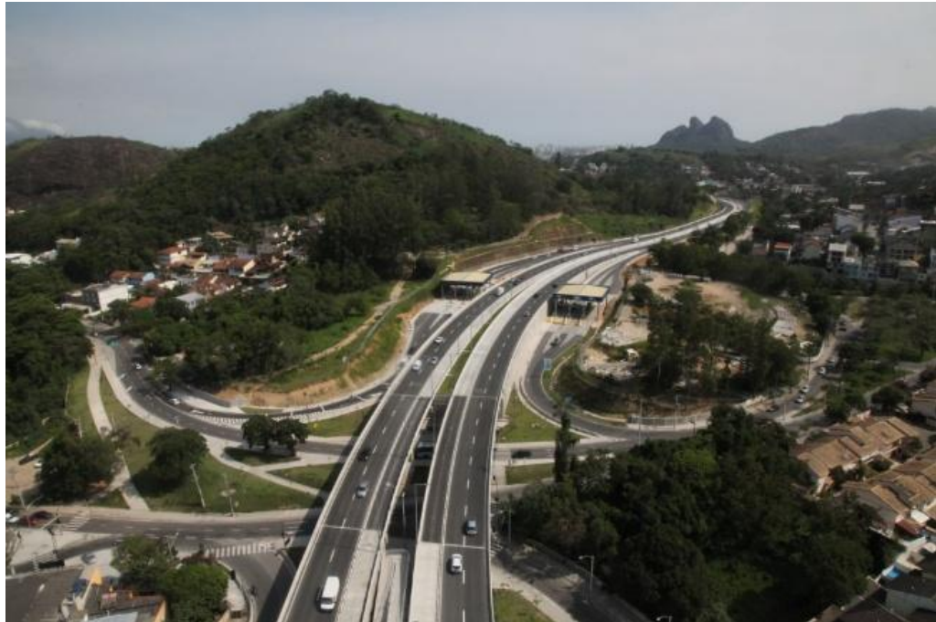
Figura 16: Viaduto e alças de entrada e saída pedagiadas sobre a Estrada do Rio Grande.
