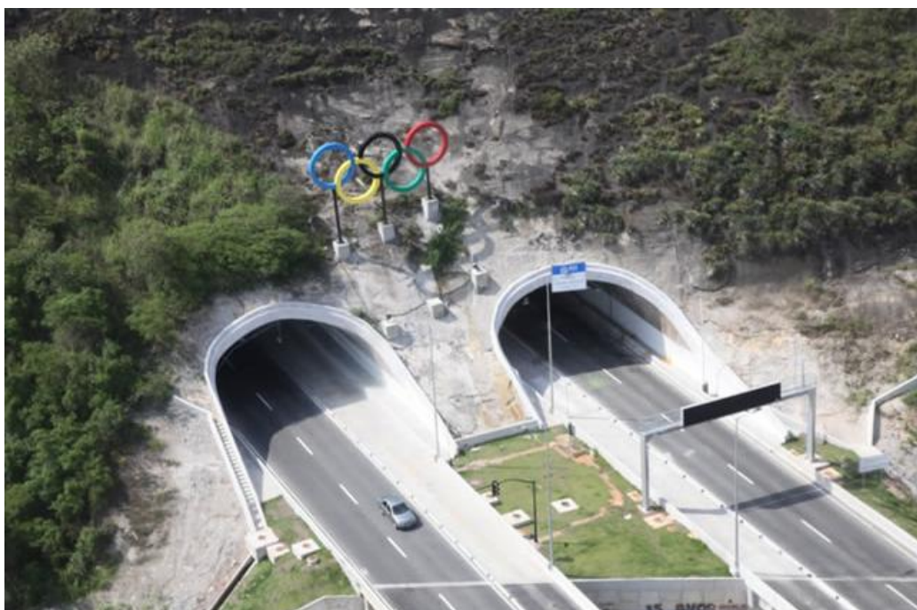
Figura 15: Desemboque do túnel Boiuna sobre o viaduto
