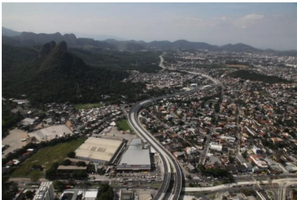
Figura 18: Final do trecho I da Ligação Transolímpica
