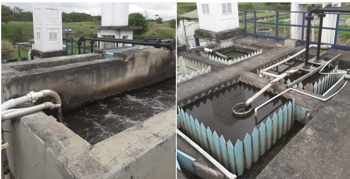
Figura 3.1. Unidades do sistema de Lodos Ativados do CESA: tanque de aeração (à esquerda) e decantadores secundários (à direita).
