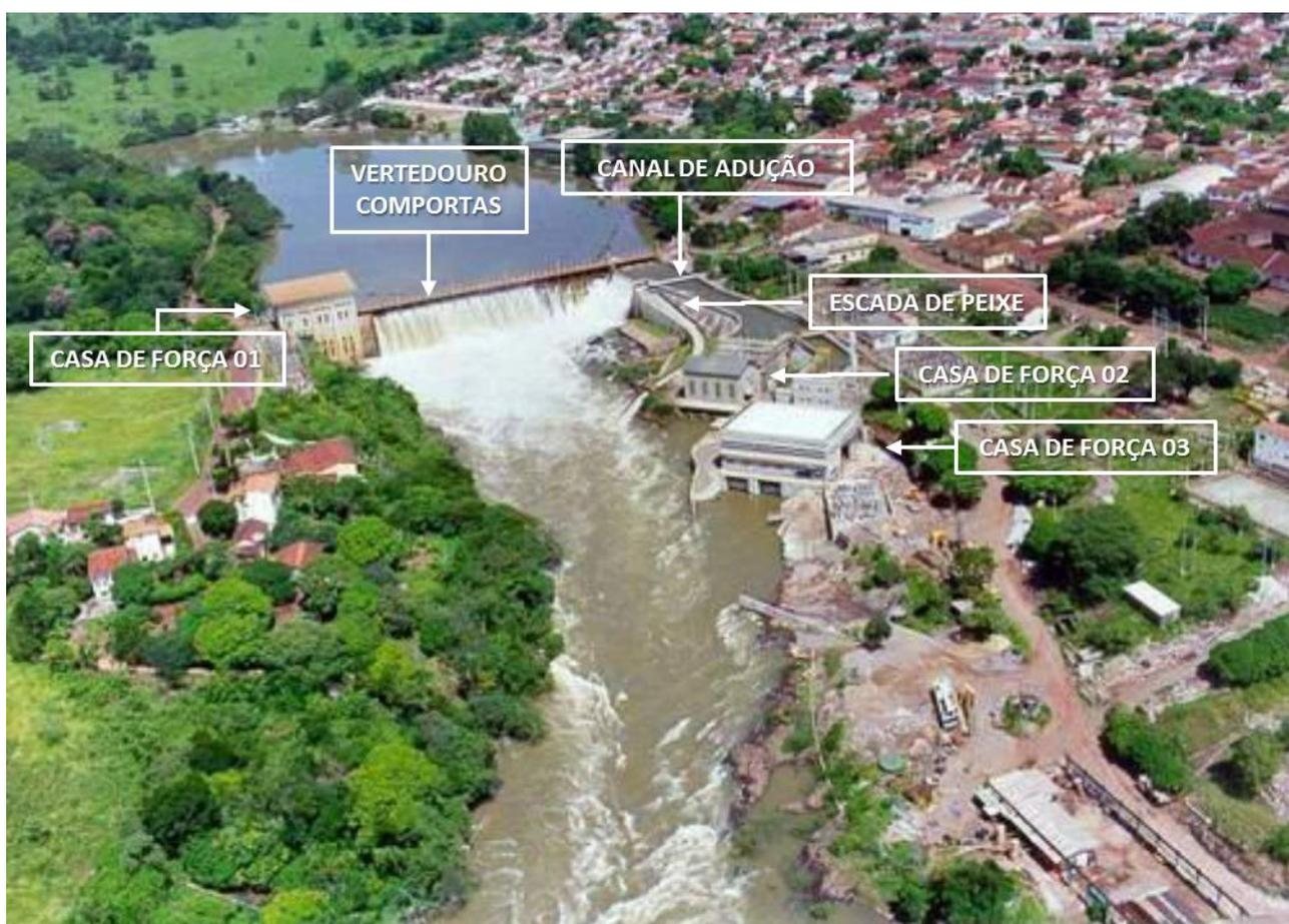
**Figura 9 - Configuração da UHE Paranapanema, constituída de três casa de força, escada de peixe, canal de adução na margem esquerda, vertedouro e comportas. (Fonte: Santa Cruz Geração, 2017)**
