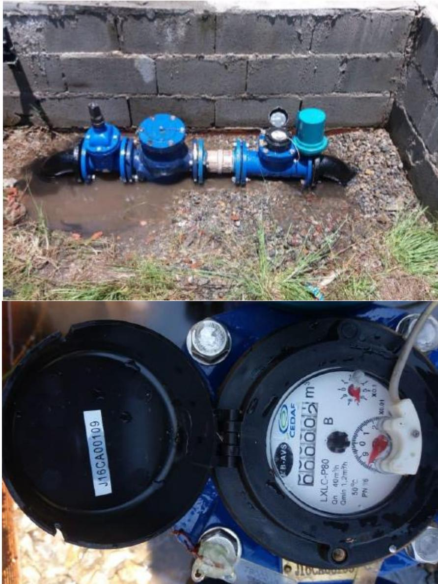
Figura 31: Macromedidor da marca KROHNE/CONAUT, 100mm, referente ao DMC Vila Residencial, após a manutenção (CEDAE, 2018)
