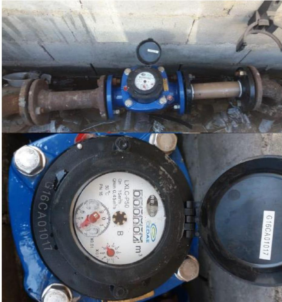
Figura 32: Macromedidor da marca KROHNE/CONAUT, 50mm, referente ao DMC Rua dos Cravos, após a manutenção (CEDAE, 2018)
