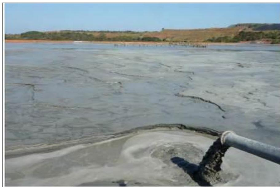
Figura 16: Disposição de rejeito em polpa - Espigote
