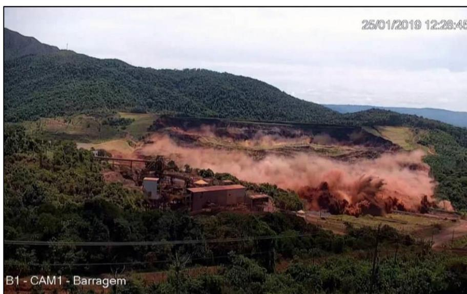
Figura 37: Rompimento da barragem de rejeitos da empresa Vale em Brumadinho. Fonte: (PAES, 2019)
