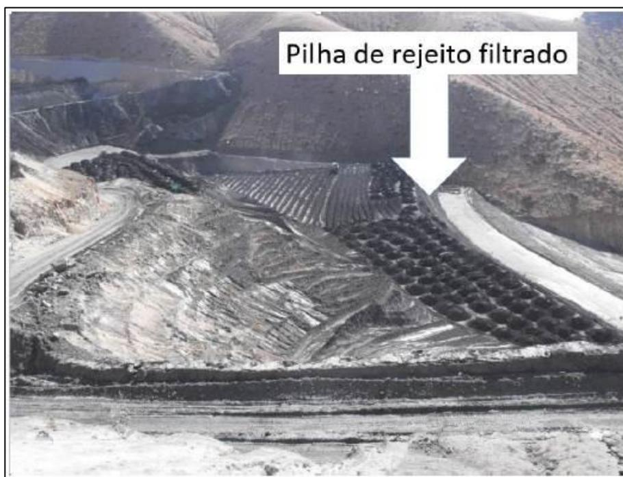
Figura 29: Pilha de rejeito filtrado (*Dry stack*) em operação na Mina Cerro Lindo, Peru.
