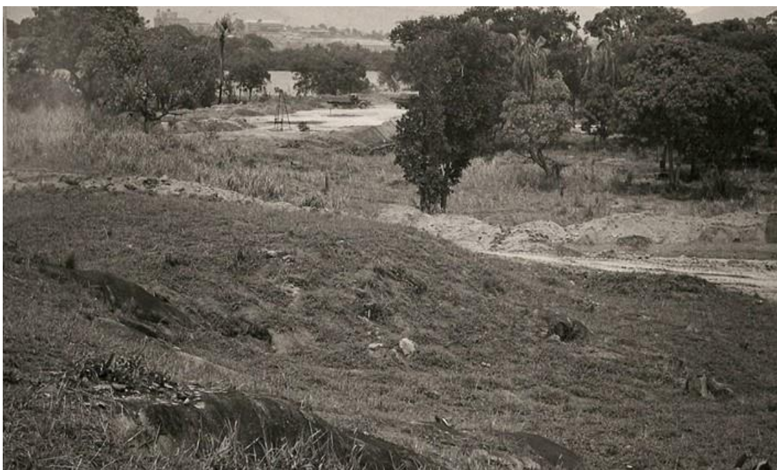
Figura 2 – Ambiente no período inicial das obras de aterros e terraplenagem no Arquipélago de Manguinhos (Foto do acervo do ETU).
