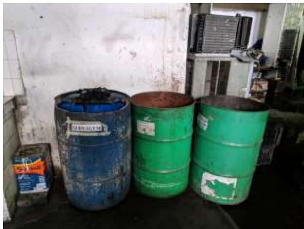
**Figura 29 - Tambores destinados a auxiliar no primeiro combate a vazamentos na divisão de atividades - caldeira.**
