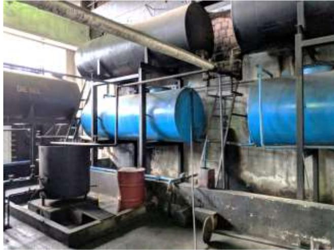
**Figura 28 - Tanques de armazenamento derivados de petróleo para abastecimento das caldeiras da divisão de atividades**
