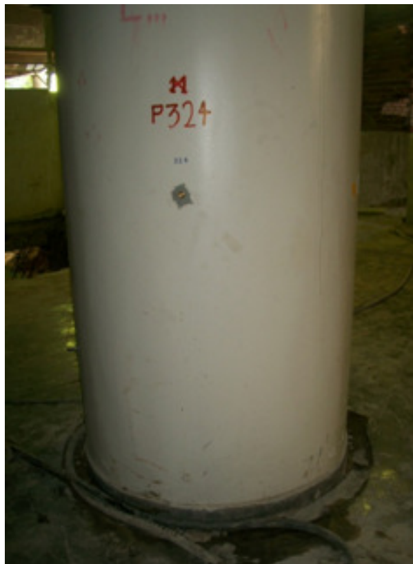
Figura 5.8 – Pilar metálico rosqueável para a medição dos recalques.
