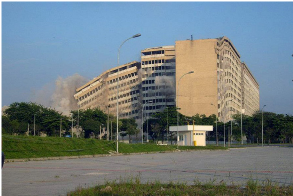
Figura 5.2 – Momento da implosão do HUCFF.
