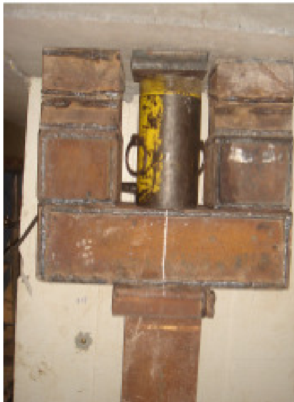
Figura 5.23 – Cunhagem das Estacas Mega.
