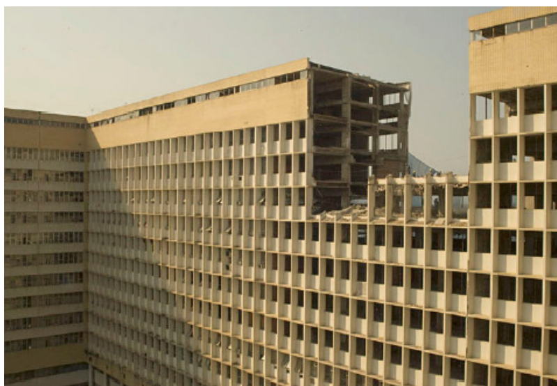
Figura 5.1 – Demolição manual – vão de 20 metros entre os Blocos AII e AIII.
