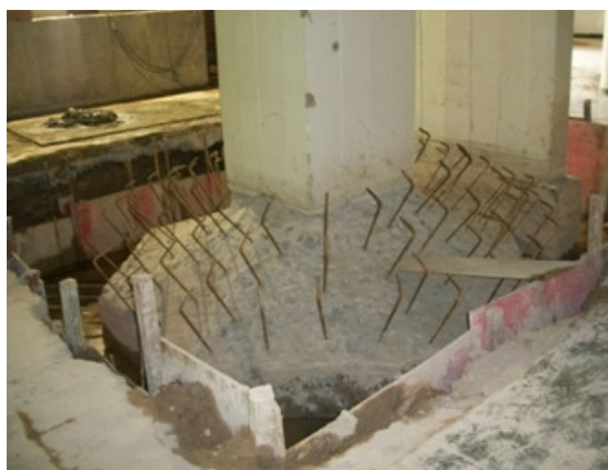
Figura 5.15 – Sapata S-314 com armaduras fixadas.
