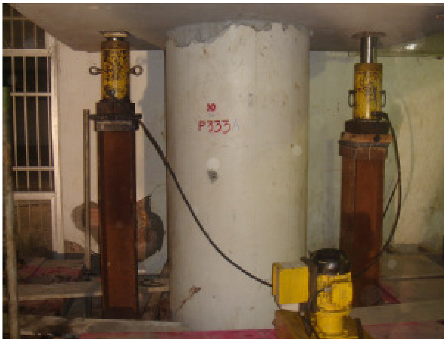
Figura 5.22 – Cravação das Estacas Mega, vendo-se atuadores hidráulicos em paralelo.
