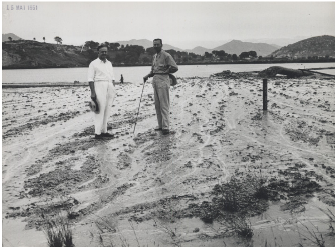
Figura 3.3 – O engenheiro Horta Barbosa inspecionando a execução do aterro hidráulico (1951).
