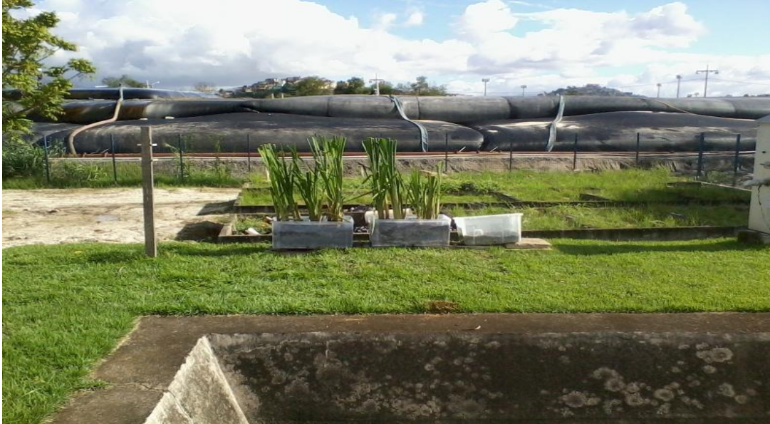
Figura 11: Wetlands em escala piloto talude da lagoa de estabilização CESA
