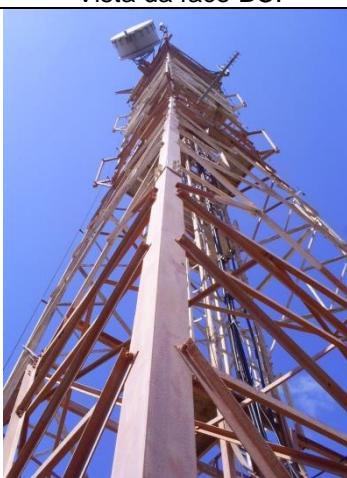
Vista do montante B.
