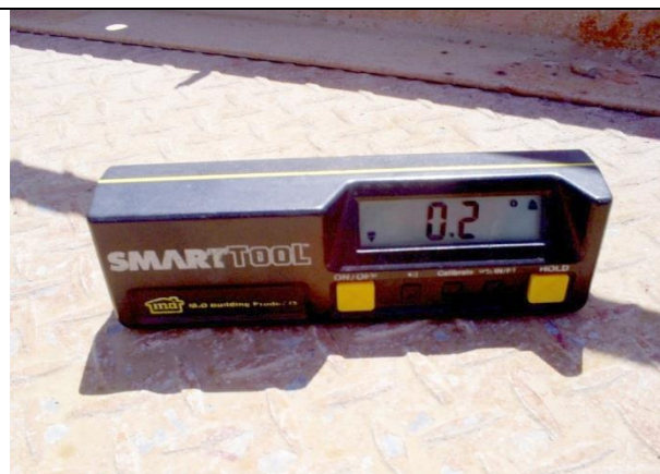
Nível da plataforma ok.
