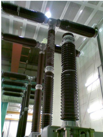
Figura 4.4 – Disjuntor ensaio de laboratório Fonte: Autor (2010).
