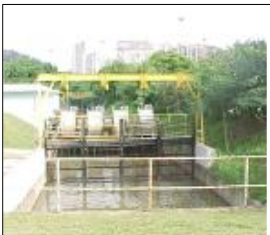
(a) Estrutura de Gradeamento.
