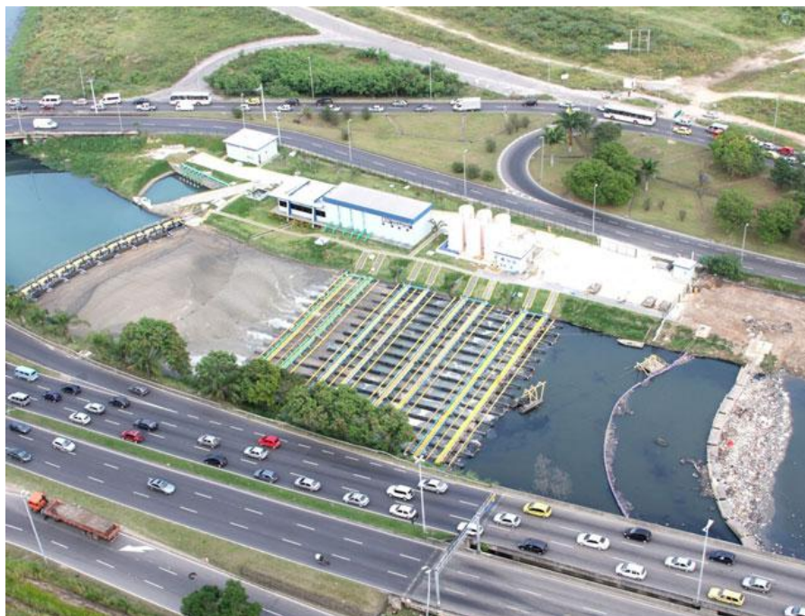
Figura 26: Unidade de Tratamento de Rio U.T.R. Arroio Fundo
