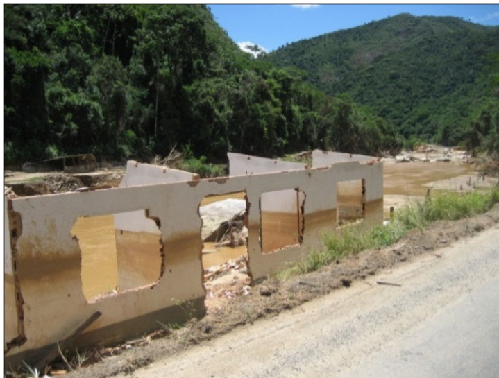
Figura 24: Casa à beira do Rio Preto e às margens da estrada, destruída pela enchente em janeiro de 2011. Foto: a autora.
