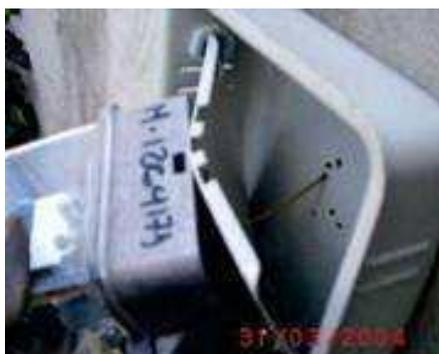
Figura 7: Caixa do medidor furada.
