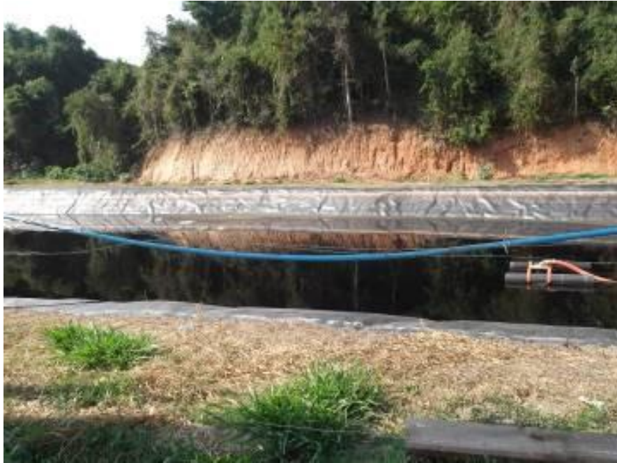
Figura 6: Tanque de recepção de lixiviado em dezembro de 2011.
