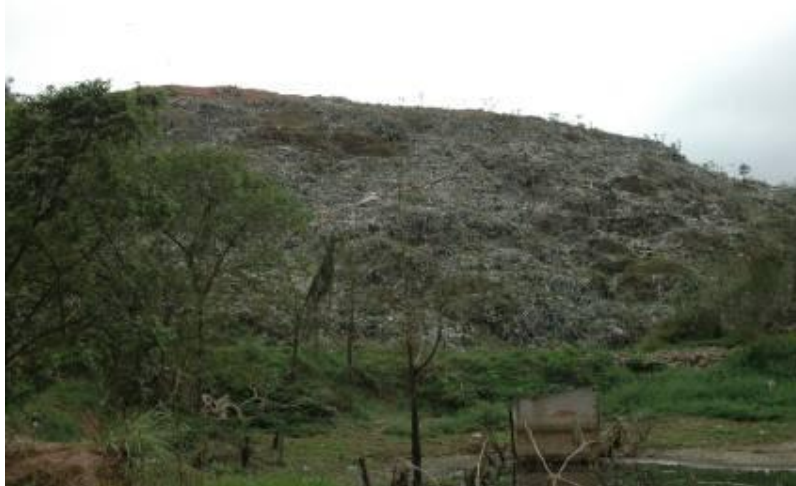
Figura 1: Maciço de resíduos sólidos quando o lixão de Volta Redonda ainda estava em operação.
