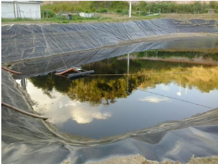
Figura 7: Tanque de recepção de lixiviado em fevereiro de 2014.
