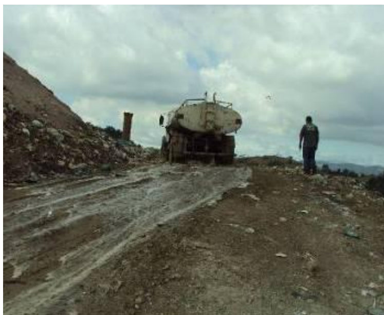
Figura 2: Caminhão recirculando o lixiviado sobre o maciço de lixo. Fonte: Prefeitura Municipal de Volta Redonda (2011) .
