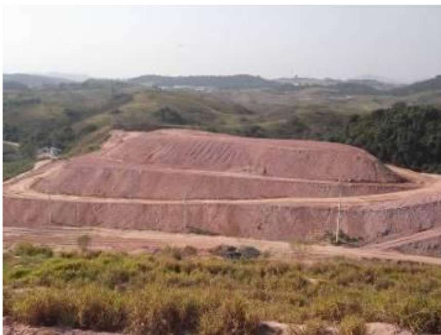
Figura 3: Aparência do lixão de Volta Redonda após encerramento. Fonte: Confeção Própria
