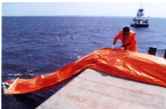
Fig.: 16 Lançamento de barreira móvel
