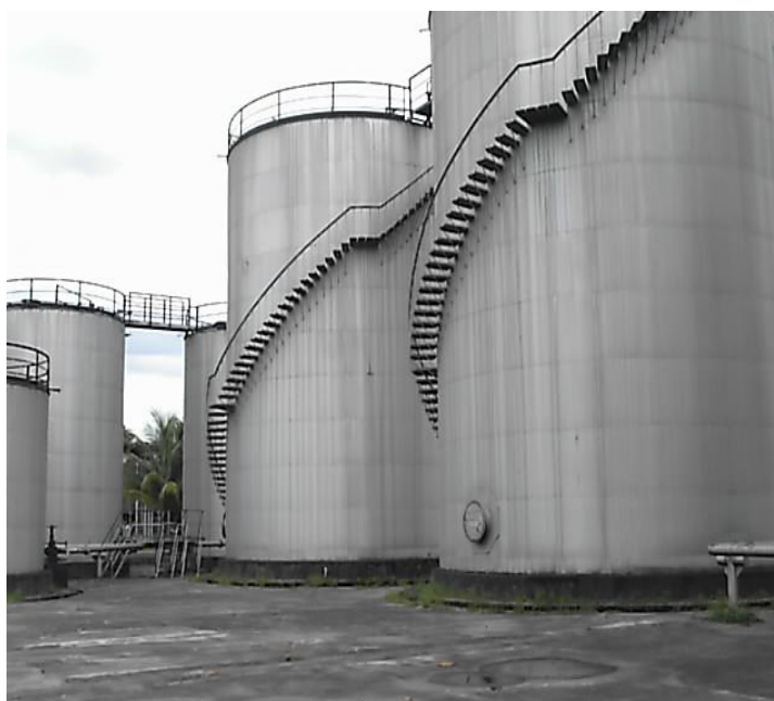
Fig. 11 – Tanque fixo de armazenamento de básicos Fonte: www.google.com.br/imagens
