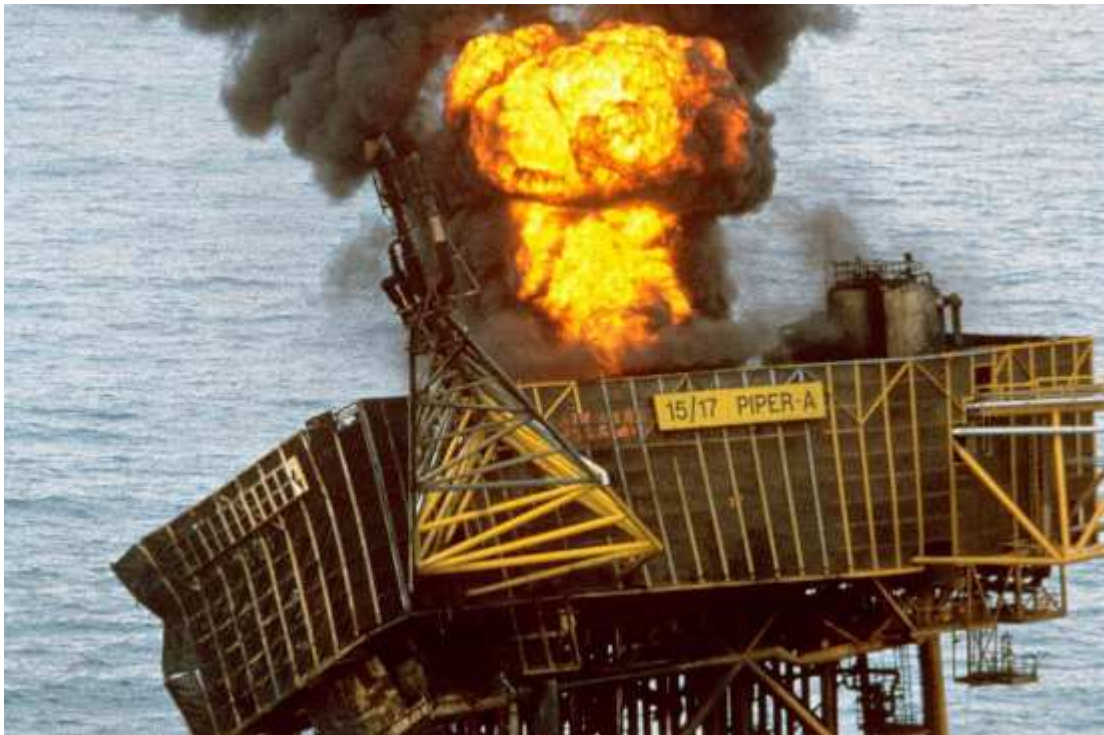
Figura 18 – Acidente da Plataforma Piper Alpha , Julho de 1988 (Fonte: www.wikipedia.org , acesso em Fevereiro de 2014)
