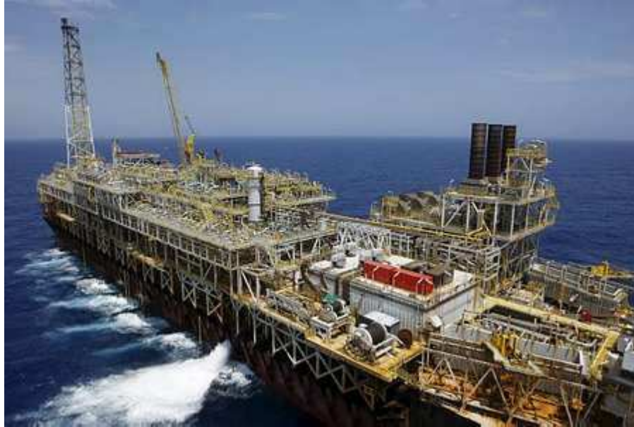
Figura 16 – Planta industrial típica de uma plataforma FPSO (Fonte: www.petrobras.com.br , acesso em Dezembro de 2013)
