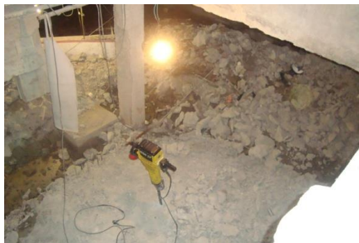
Figura 14 - Concreto – resíduo de demolição
