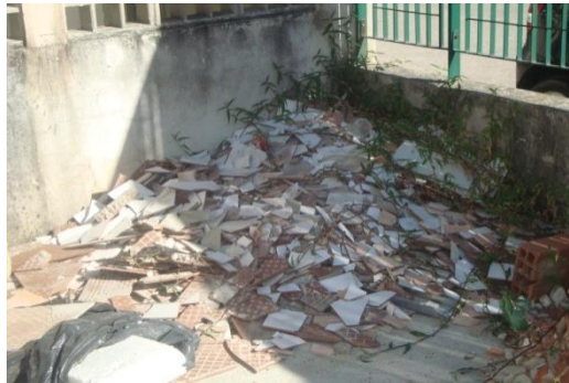
Figura 13 - Piso cerâmico – resíduo de construção
