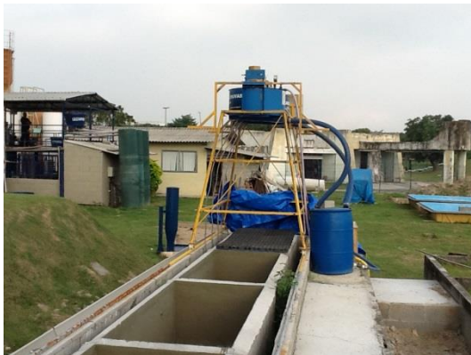
Figura 35 – Local para assentamento das placas de concreto reciclado, para teste de permeabilidade - CESA/UFRJ
