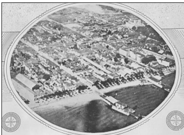
Figura 08 - Estação hidroviária. Fonte: História de Niterói, 2010
