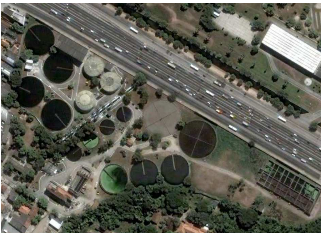
Figura 13: ETE Penha, vista aérea Fonte: Google Earth, 2014
