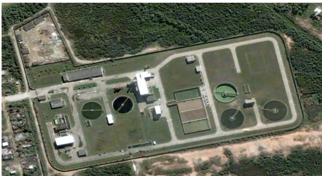
Figura 17: ETE Sarapui, vista aérea Fonte: Google Earth, 2014
