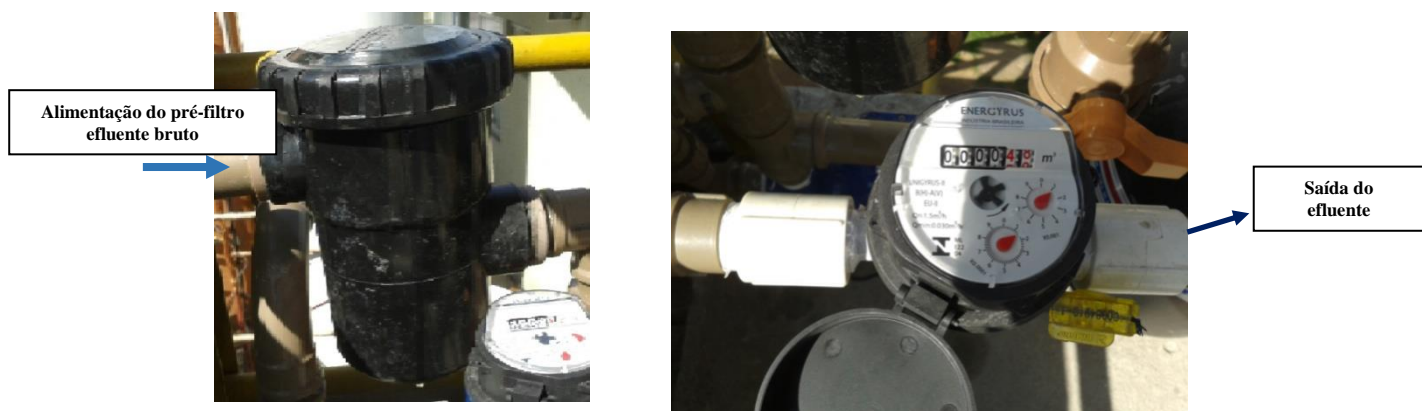
Figura 14 - Sistema de pré-filtração e hidrômetro instalados na ETAC – CESA.
