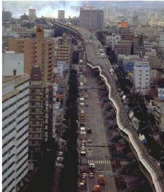
Figura 5 – Viaduto de Hanshin danificado após terremoto de Kobe, Japão em 1995.
