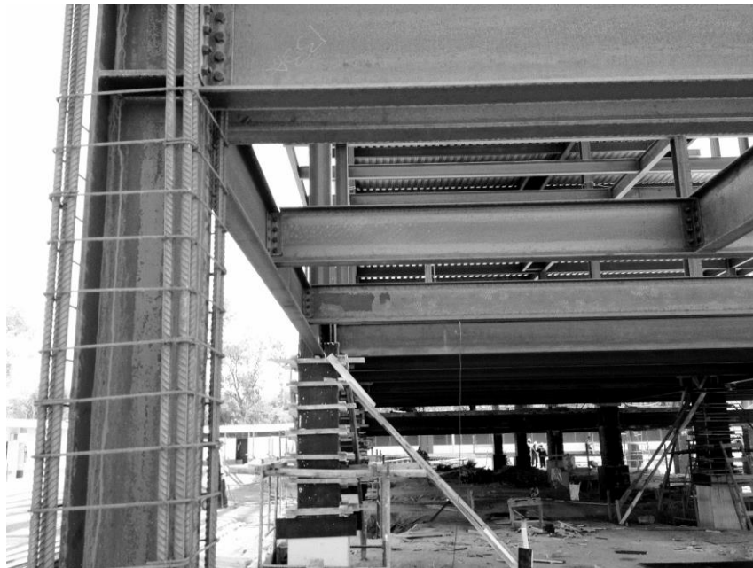
Figura 3.5 - Detalhe dos pilares ainda sem o encamisamento
