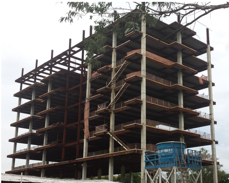
Figura 3.3 - Construção do Bloco 34
