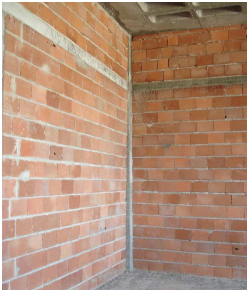
Figura 5-4 – Foto do pilar em estudo sem o revestimento.
