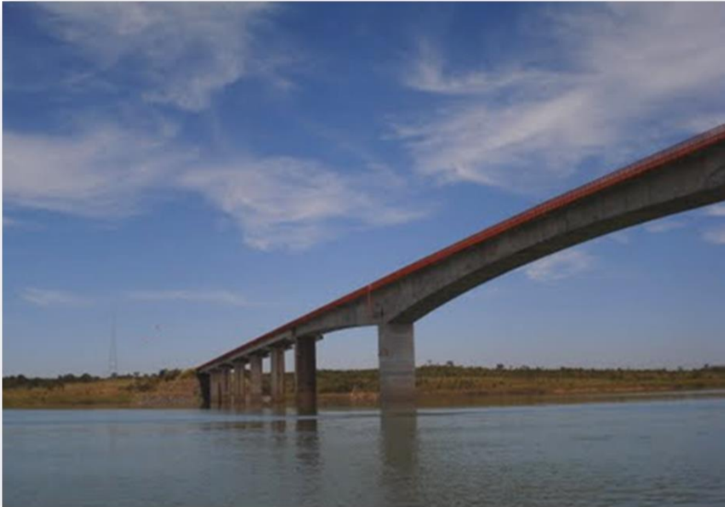
Figura 1 f - Ponte sobre o Rio Maranhão
