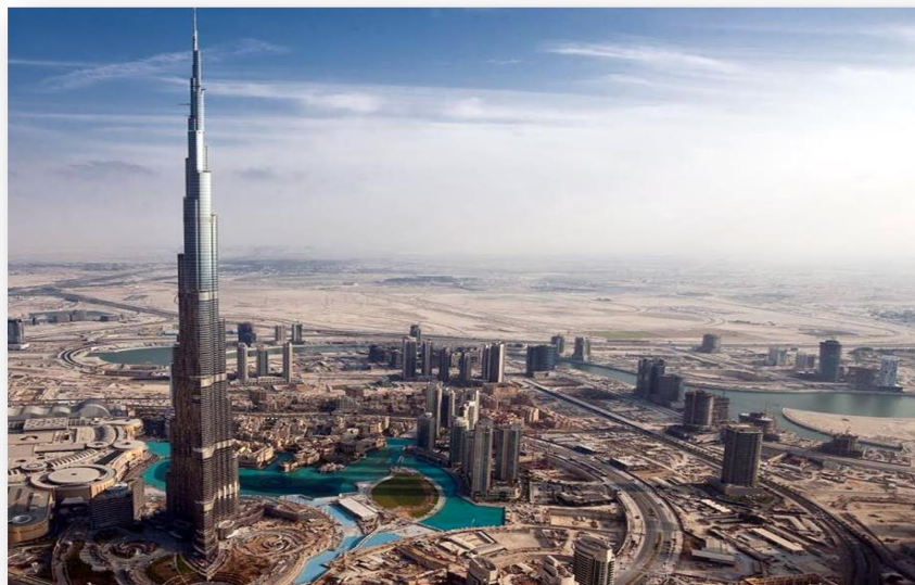
Figura 1 e - Burj Khalifa - Vista da estrutura concluída
