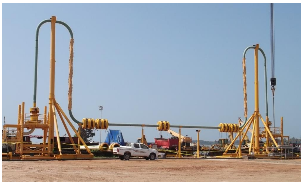
Figura 2-3 – Jumper rígido com Strakes no canteiro (Foto do Autor).
