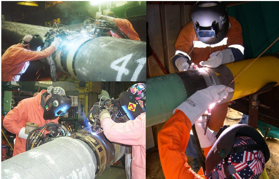
Figura 2-19 – Processo de soldagem dos tubos no canteiro (Cortesia SAIPEM).
