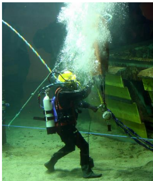
Figura 2-9 – Conexão de Spool assistida por mergulhador (UNDERWATER, 2011).
