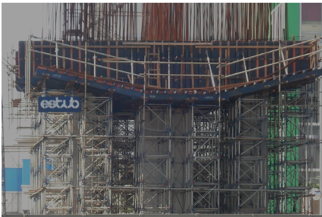
Figura 2 - Escoramento tubular de ponte em balanços sucessivos - Metrô de São Paulo
