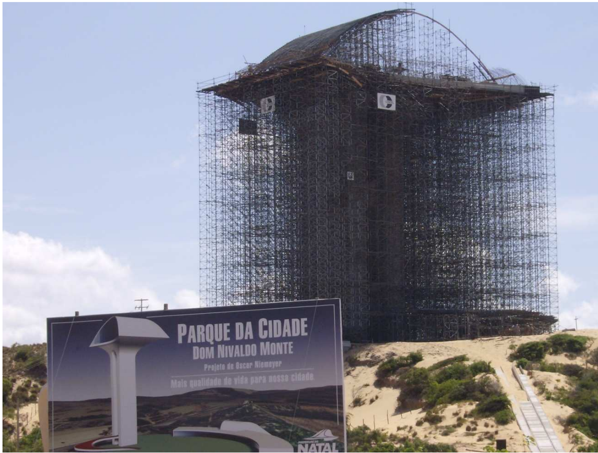
Figura 4 - Escoramento de cúpula em Natal-RN
