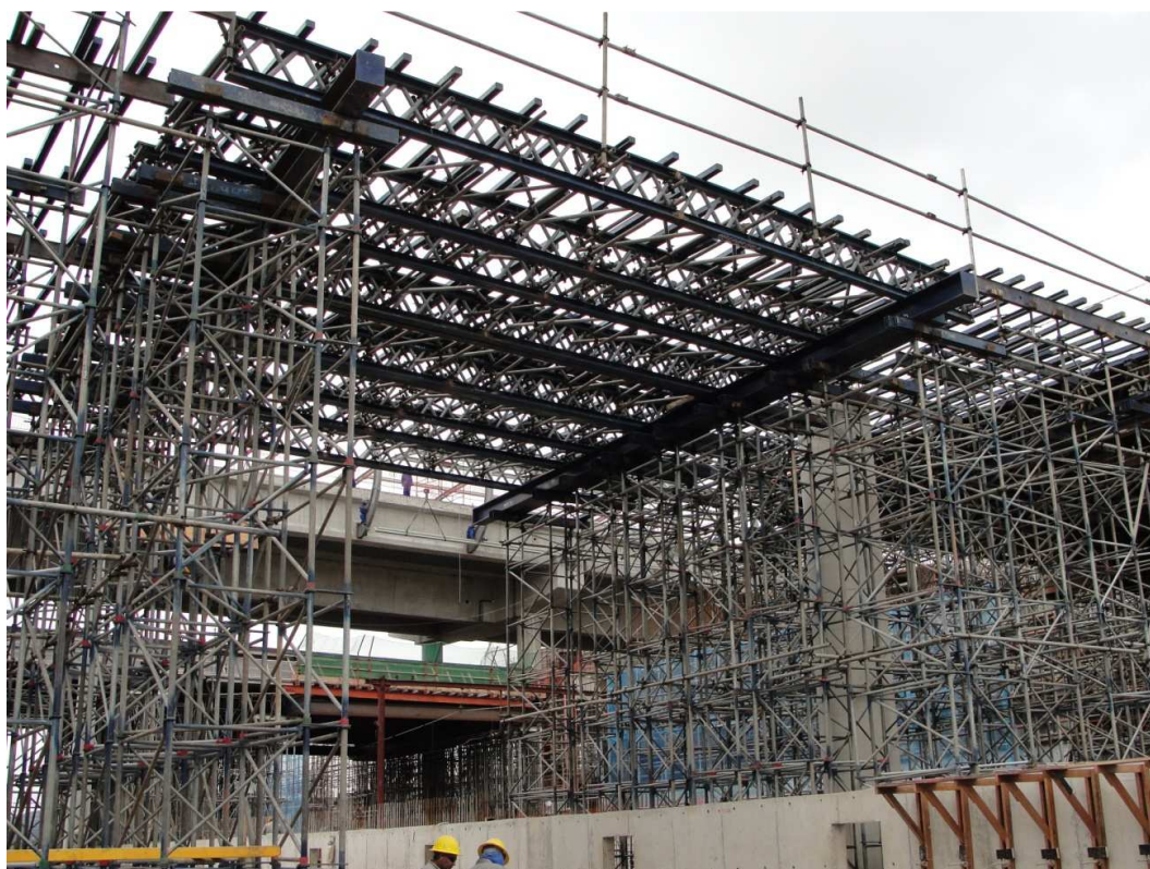
Figura 3 - Escoramento de viaduto em São Paulo-SP
