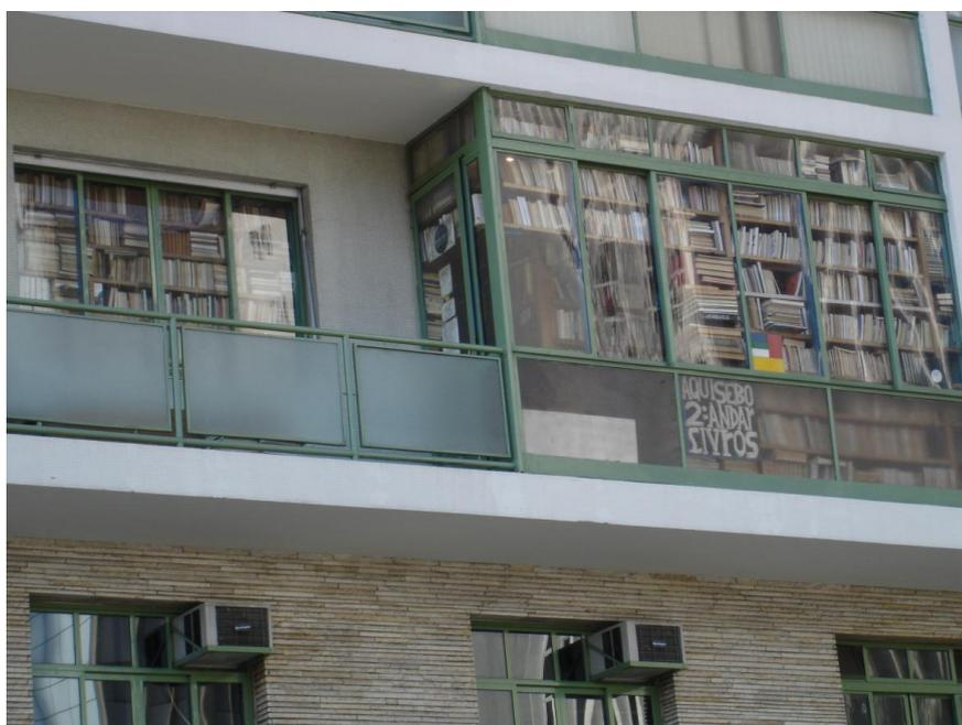
**Imagem 10** - Uso inadequado provocando sobrecarga não prevista. Fonte: Revista CONCRETO - Vida útil e desempenho das edificações na ABNT: NBR 15575/2013. Disponível em: < <http://ie.org.br/site/ieadm/arquivos/arqnot7715.pdf> >. Acesso em: 12 mar 2015.
